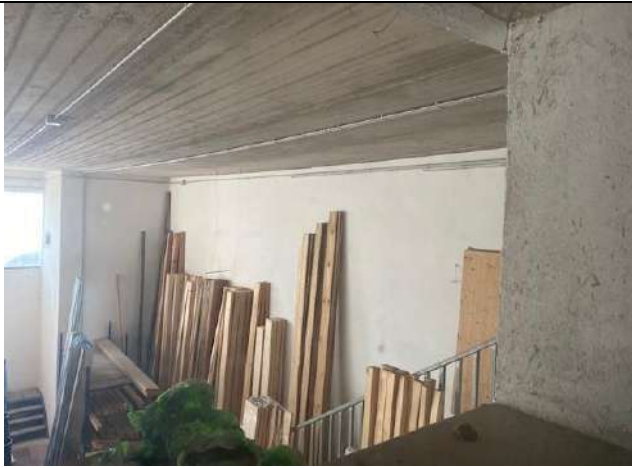
Foto 12: vista del capannone dalla luce aperta sul disimpegno a primo piano visibile nella foto 9
