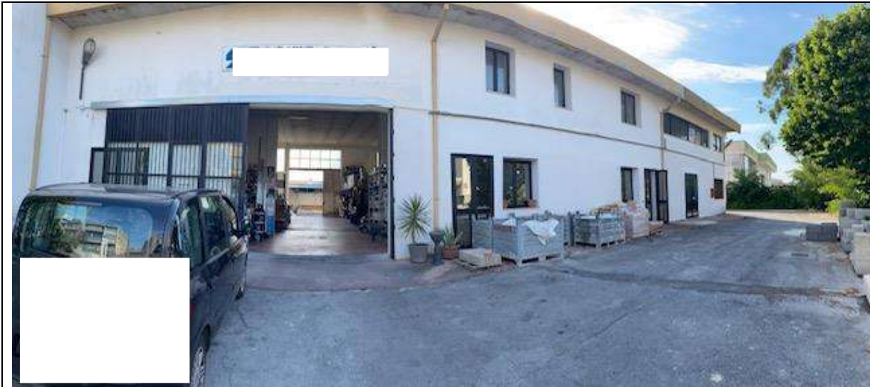
Foto 1: vista prospetto principale
