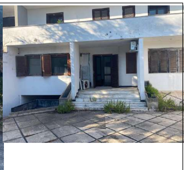
Figura 4: Ingresso posteriore di accesso al cortile
