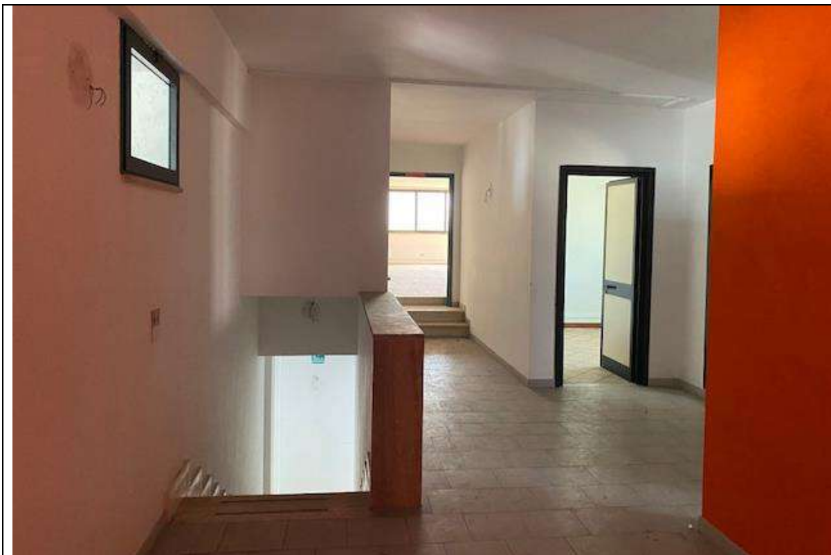
Foto 6: sbarco della scala al primo piano. Vista del disimpegno dei vani - ufficio. La porta su sulla destra è un piccolo ufficio (foto 8), da quella sulla sinistra, salendo tre gradini, si accede ad uno stanzone open-space
