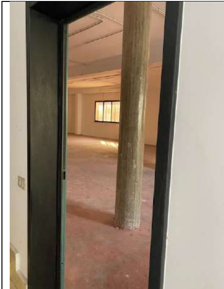
Foto 4: accesso allo stanzone a piano terra dal corridoio di ingresso.
