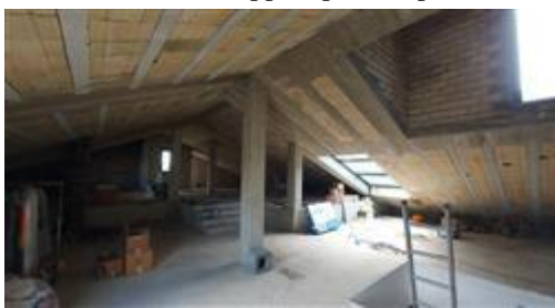
vista del piano sottotetto al grezzo
