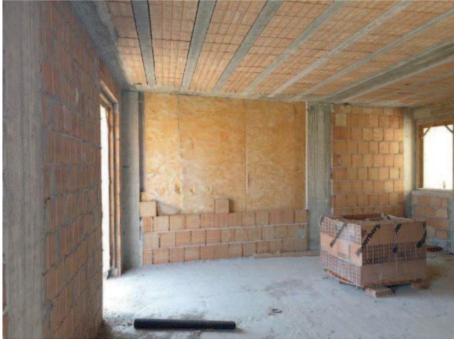
FOTO 09 – Interno villette in corso di costruzione, piano primo
