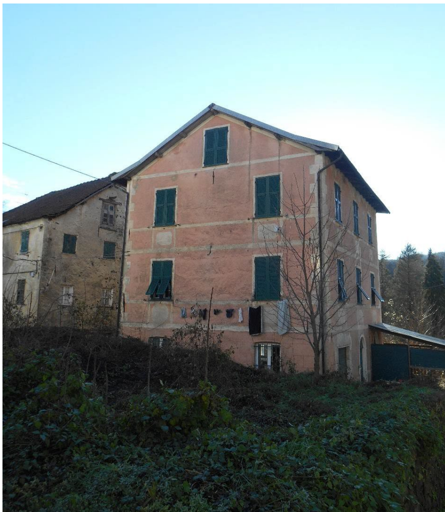
FOTO 1: Prospetti Est e Nord
