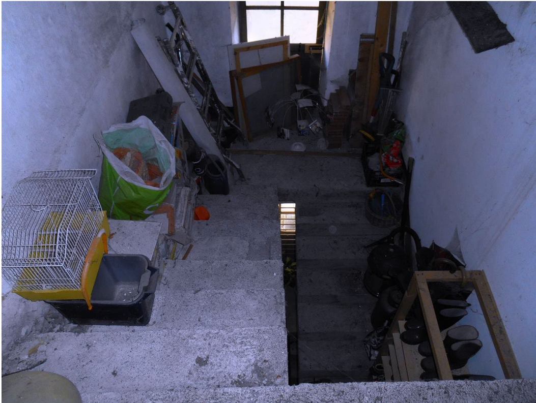
FOTO 14: Scala di accesso al sottotetto
