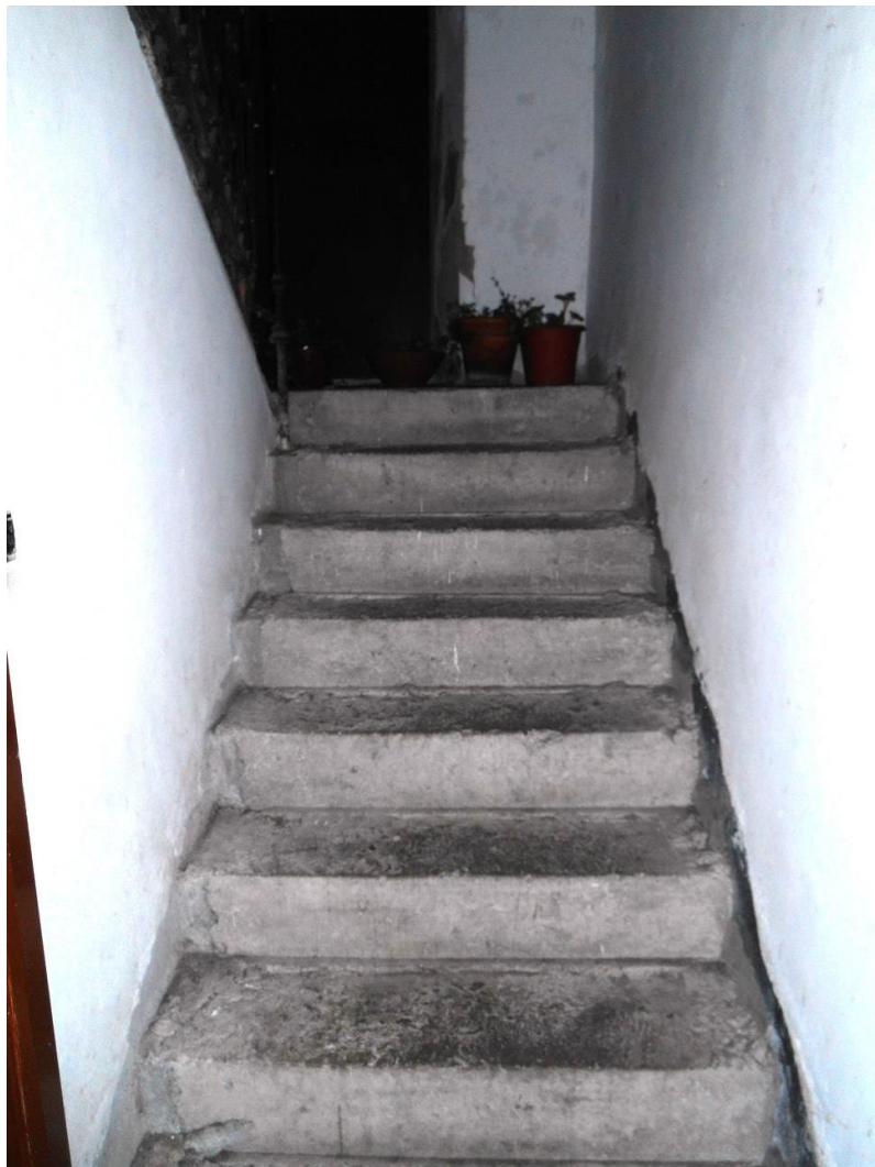
FOTO 5: Vano scala condominiale
