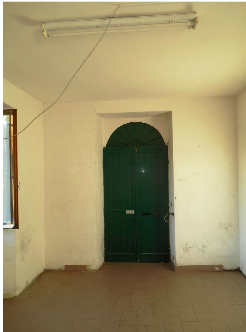
FOTO 6: Locale al Piano Terra (Magazzino)
