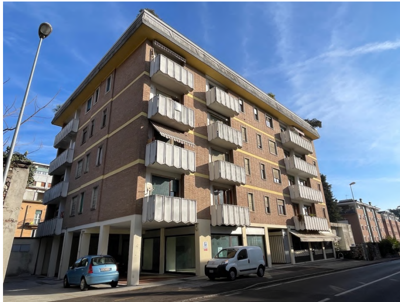
Foto 1. Inquadramento generale - Sud- vista da Via Venezia
