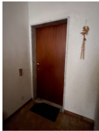
Foto 5. Porta d'ingresso appartamento
