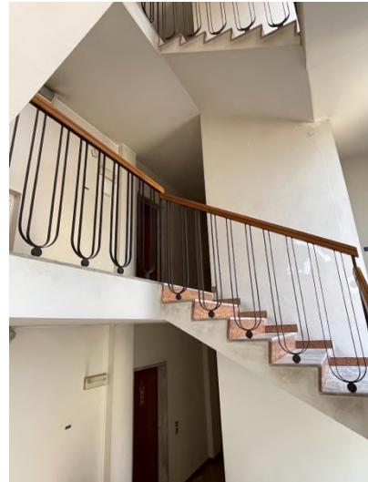
Foto 3. Vano scala comune
