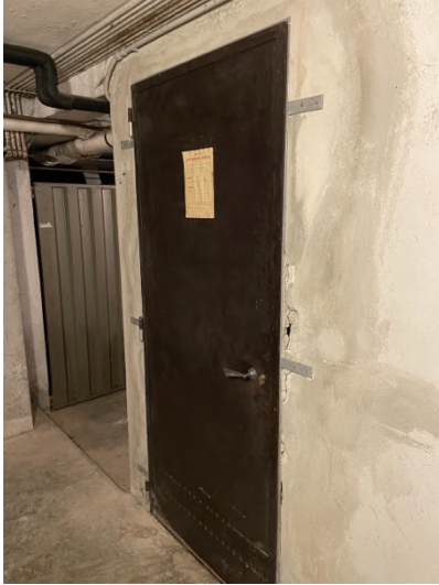
Foto 18. Corridoio comune piano interrato
