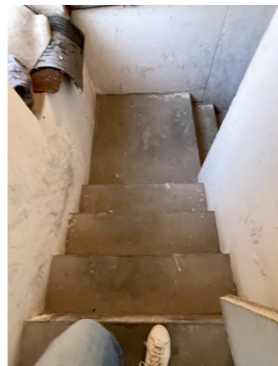
Foto 17. Accesso al piano interrato
