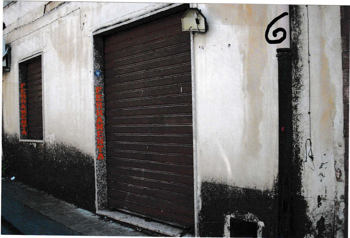
Vano terreno - via Regina Elena 51
