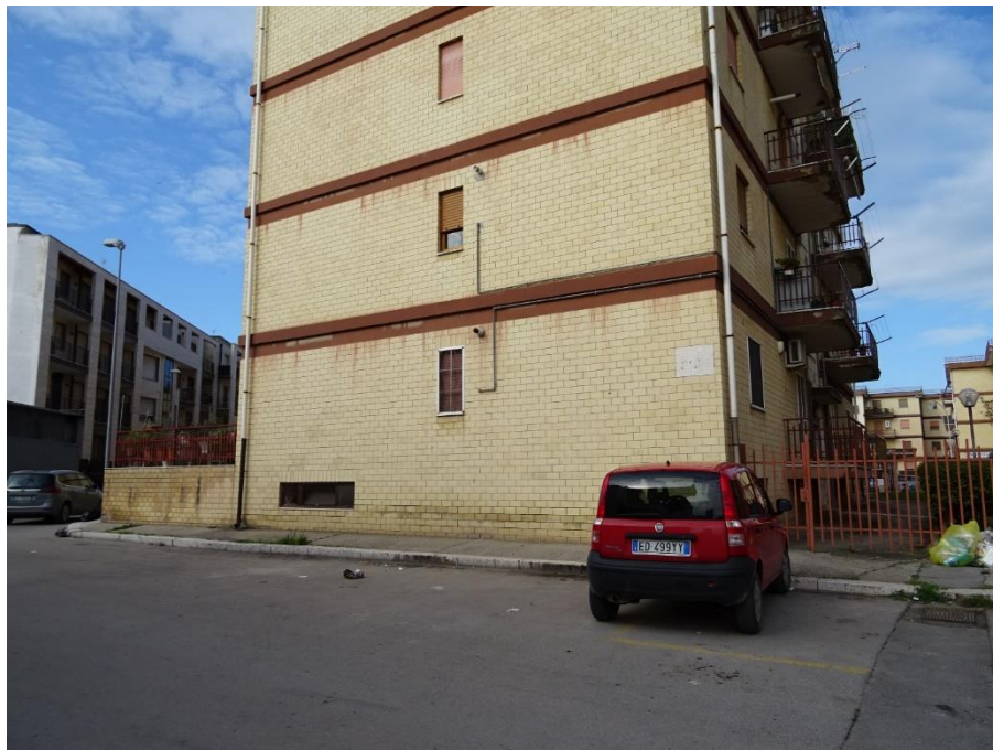
Foto n. 4: Vista laterale Immobile Orta Nova NCEU Foglio 22 P.Ila 717
