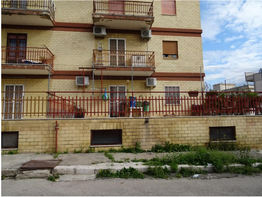
Foto n. 5: Vista posteriore Immobile Orta Nova NCEU Foglio 22 P.IIa 717
