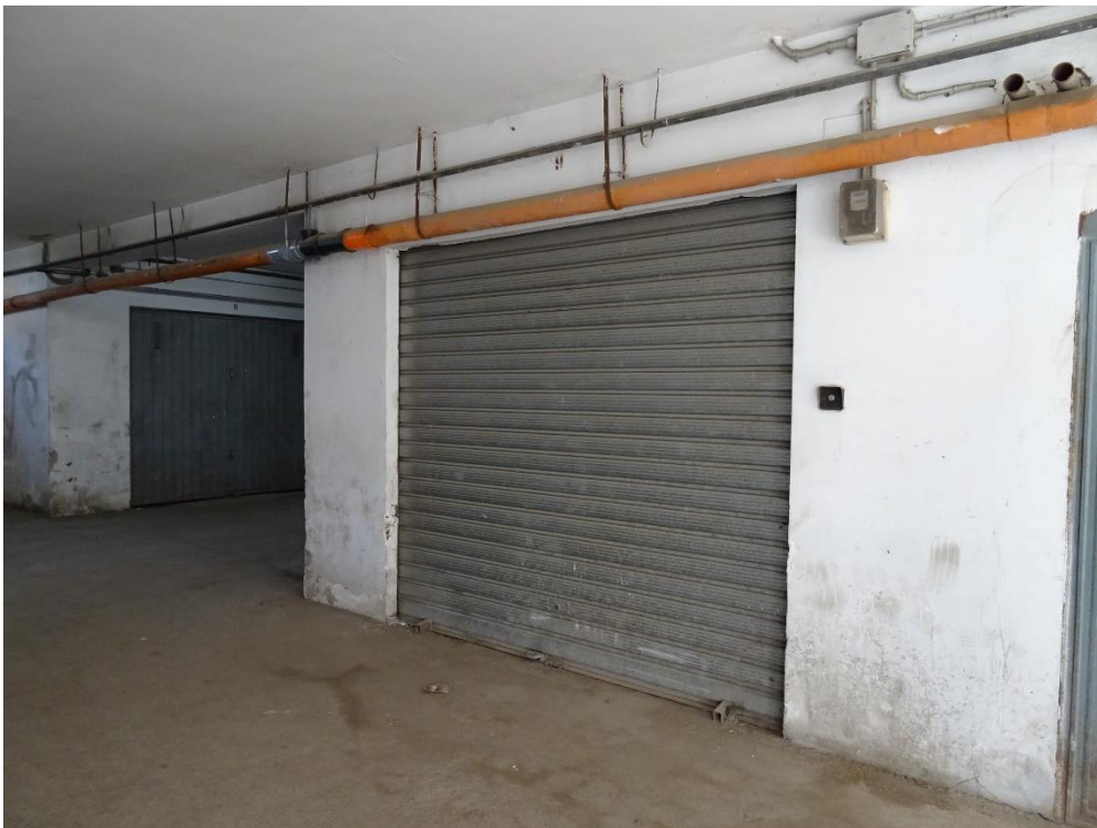
Foto n. 25: Ingresso Immobile Orta Nova NCEU Foglio 22 P.IIa 717 sub.41
