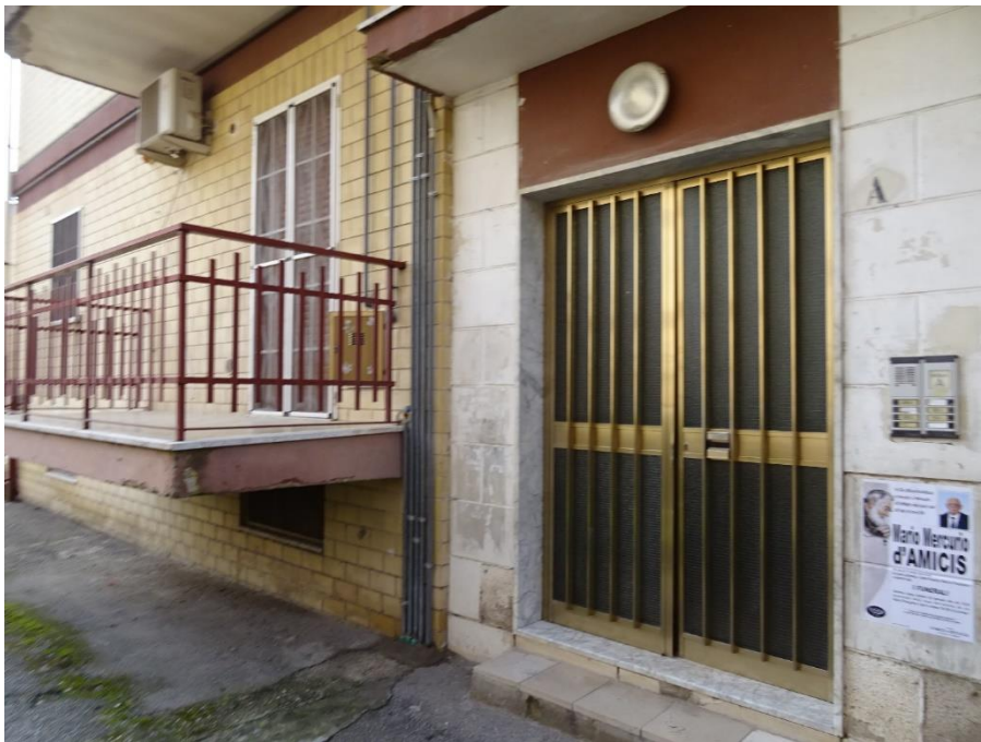
Foto n. 2: Ingresso Immobile Orta Nova NCEU Foglio 22 P.IIa 717
