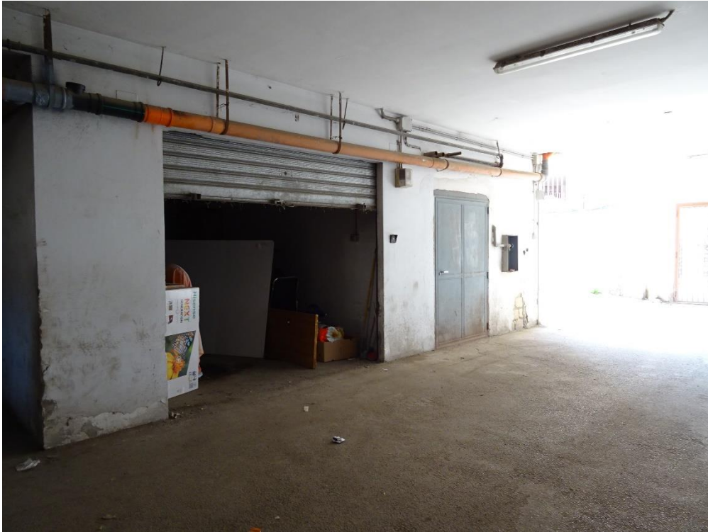
Foto n. 26: Ingresso Immobile Orta Nova NCEU Foglio 22 P.IIa 717 sub.41
