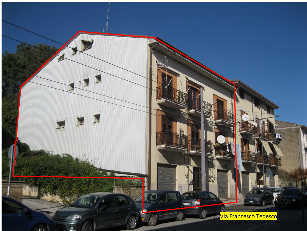
Foto 3 - Vista fabbricato comprendente l'unità immobiliare pignorata
