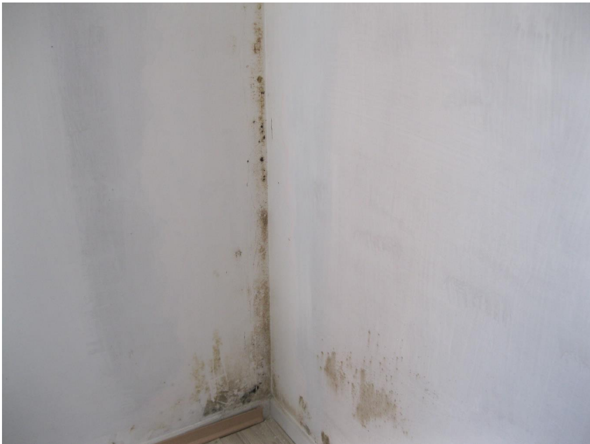
Foto 23 - Particolare pareti camera 1
