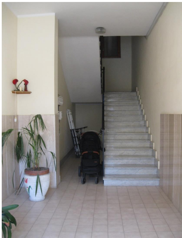
Foto 8 - Androne e scale condominiali
