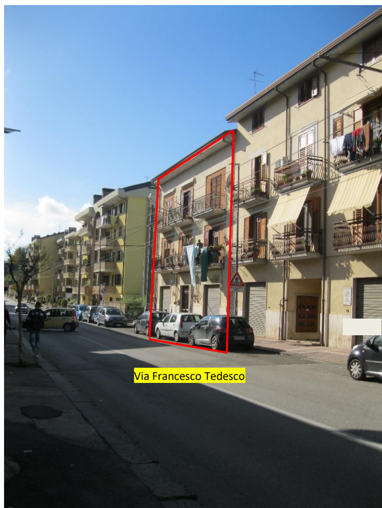
Foto 4 - Vista fabbricato comprendente l'unità immobiliare pignorata
