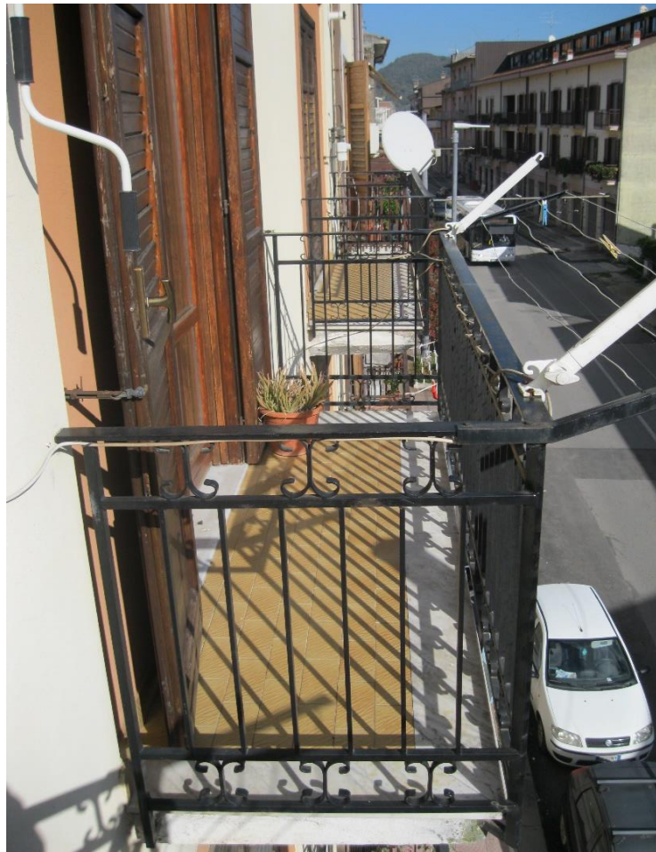
Foto 36 - Balcone a servizio del soggiorno
