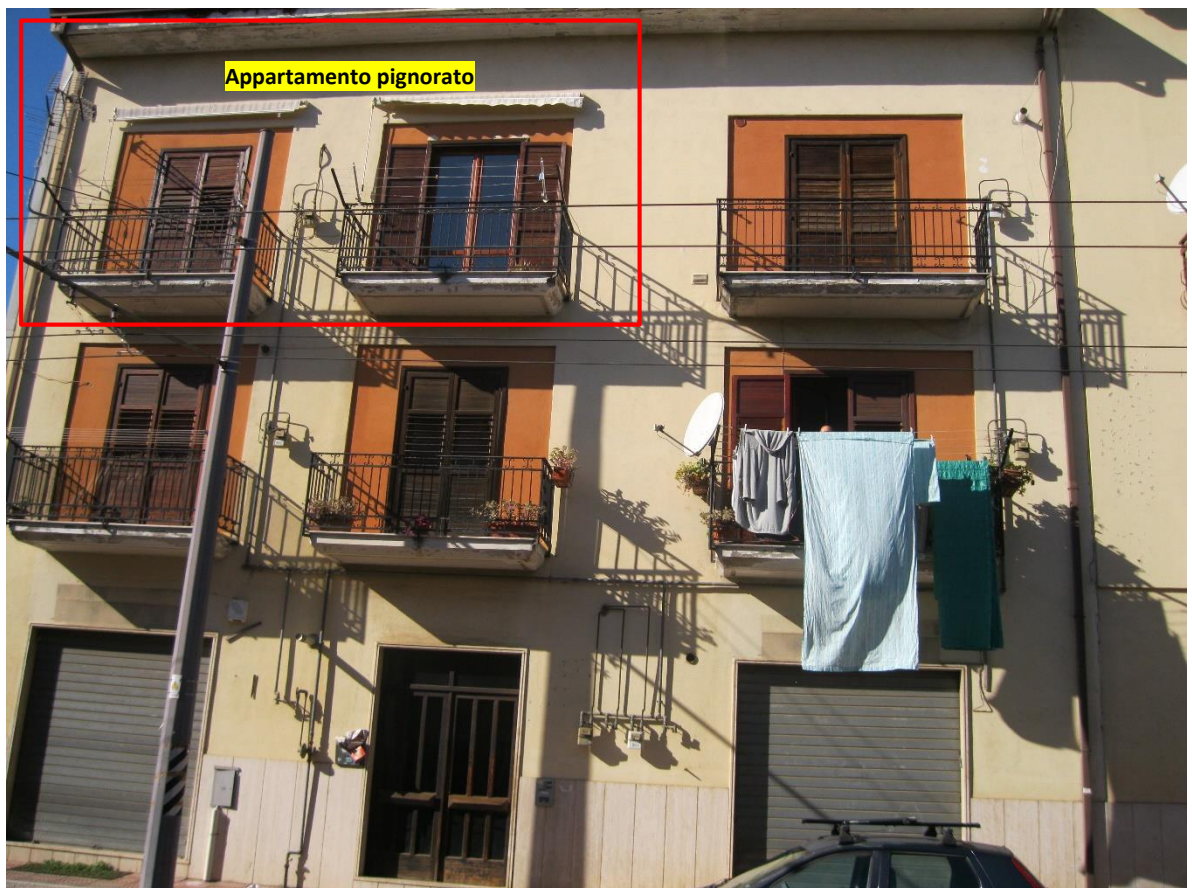
Foto 6 - Vista unità immobiliare pignorata
