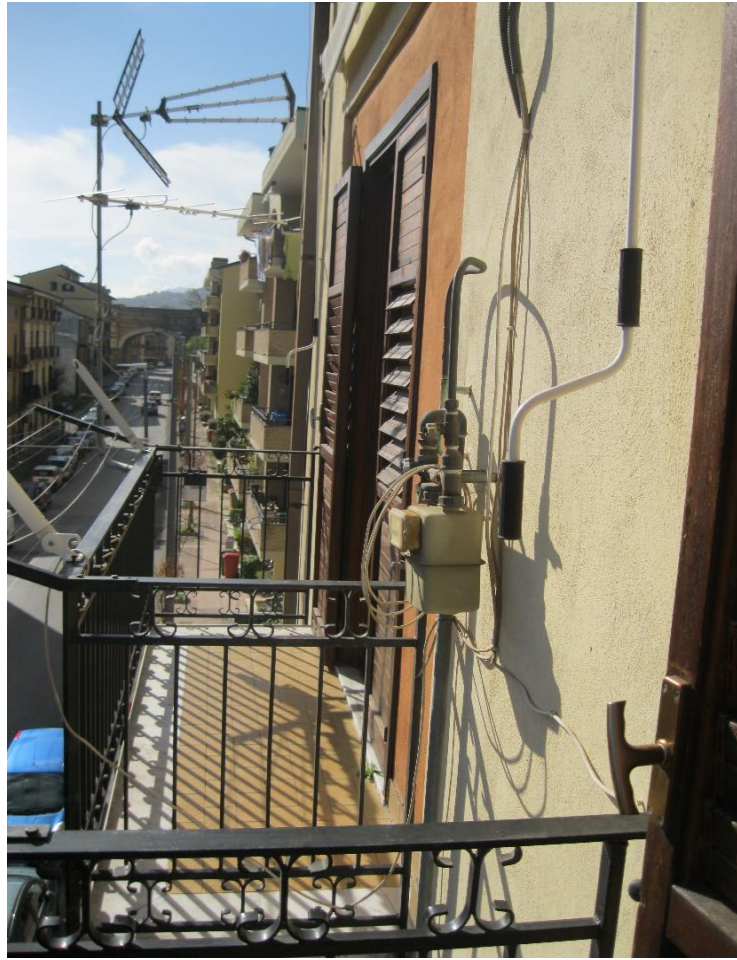
Foto 35 - Balcone a servizio della camera 1
