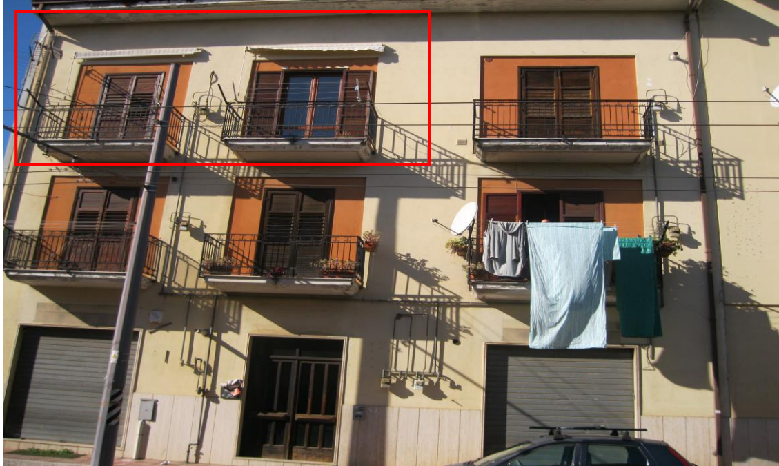
- Vista esterna del fabbricato, con individuazione dell'unità immobiliare oggetto di stima -
