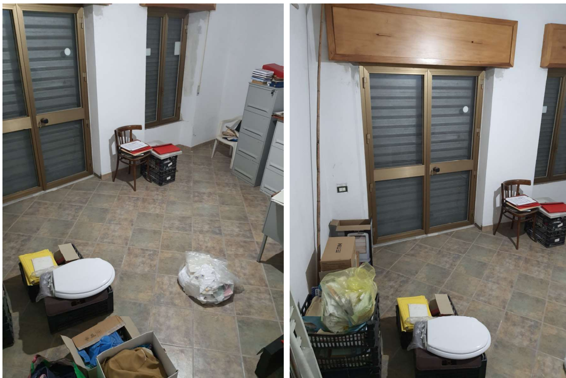
Foto vista interna locale al foglio 38 particella 1364 sub 2
