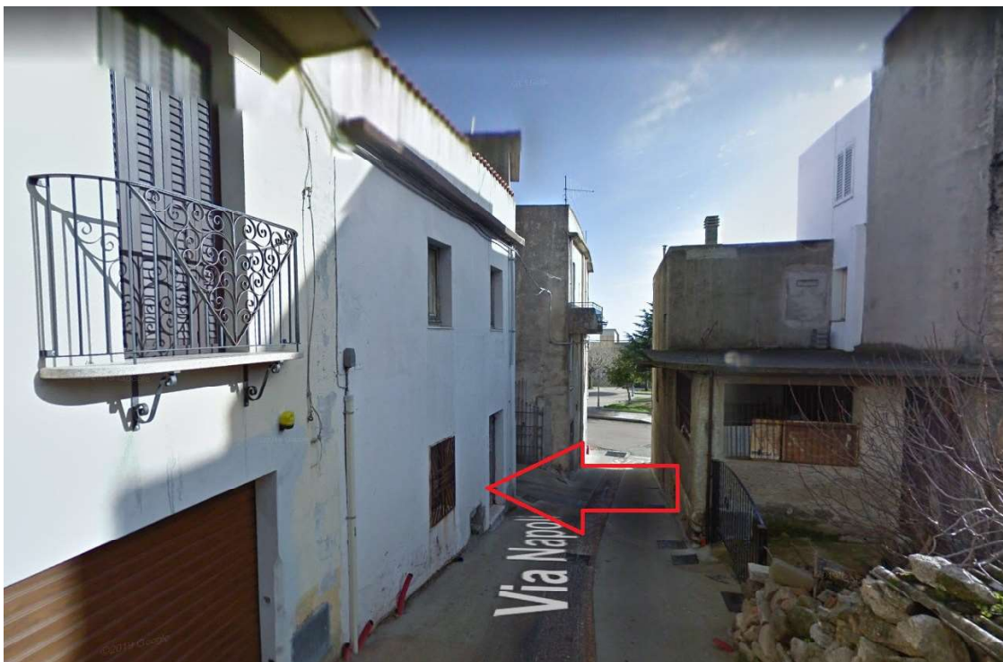
Foto viste esterne locale commerciale al foglio 38 particella 1336 sub 4
