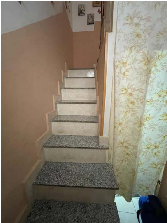
Vista del vano scala
