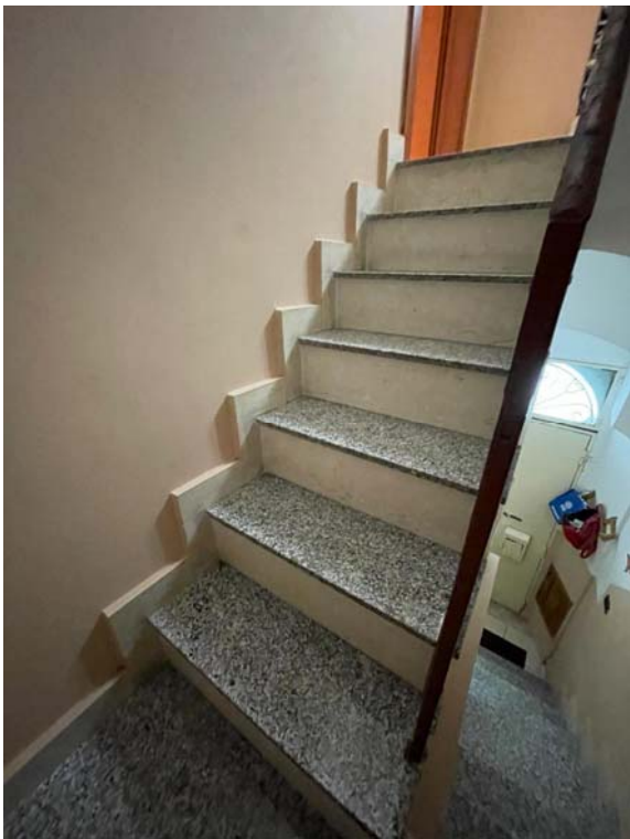
Vista del vano scala
