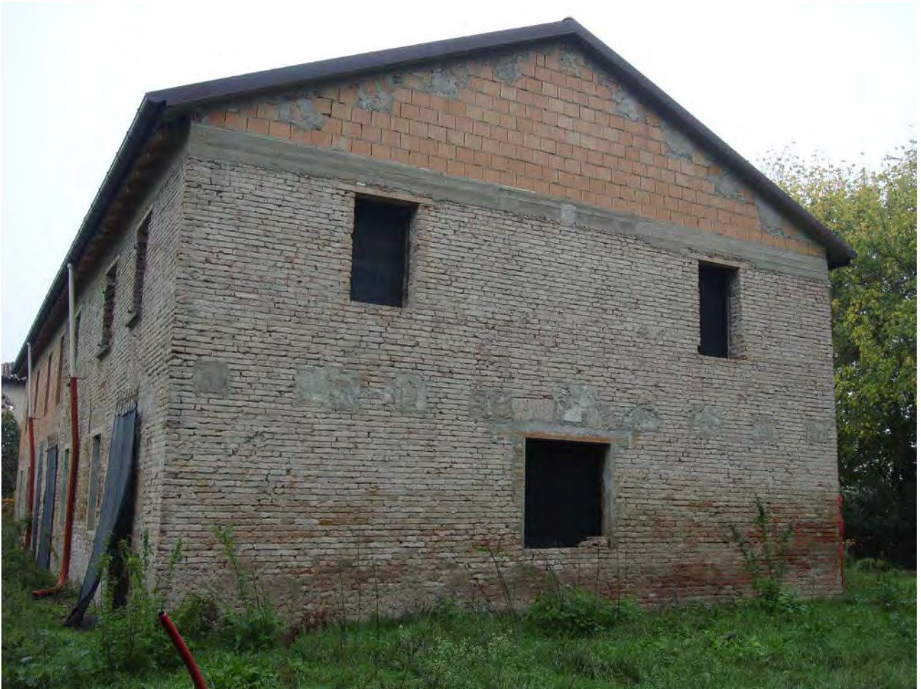
Foto 24. Mapp. 119. Prospetto Sud-Ovest.
