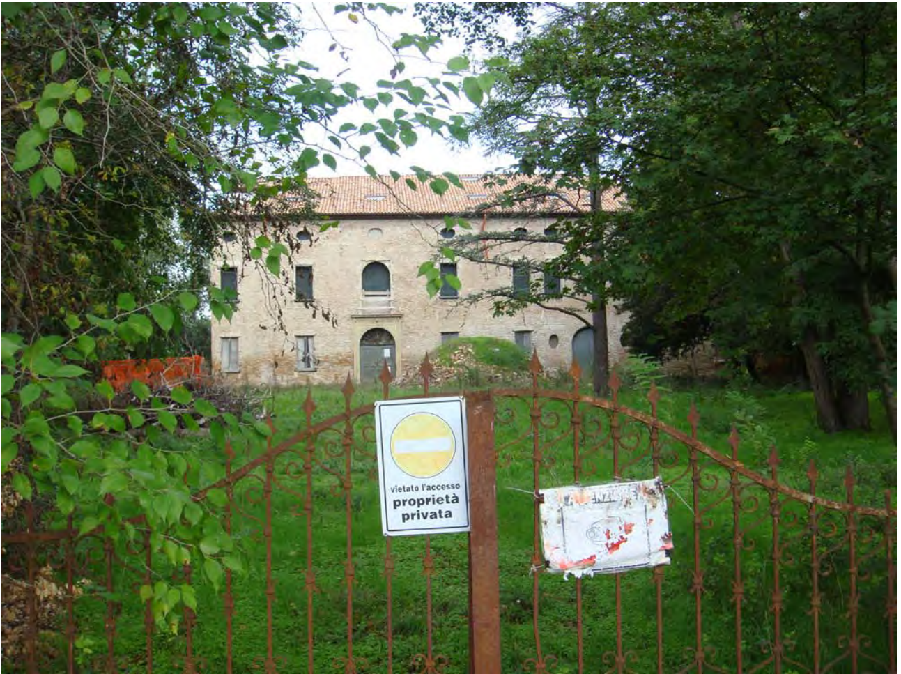
Foto 5. Mapp. 23. Prospetto Sud-Est.
