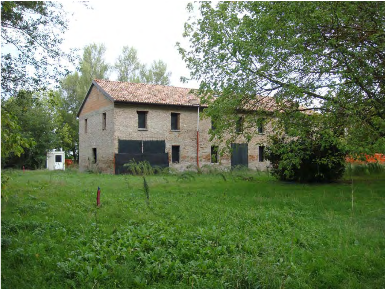
Foto 21. Mapp. 119. Prospetto Sud-Est e prospetto Sud-Ovest.
