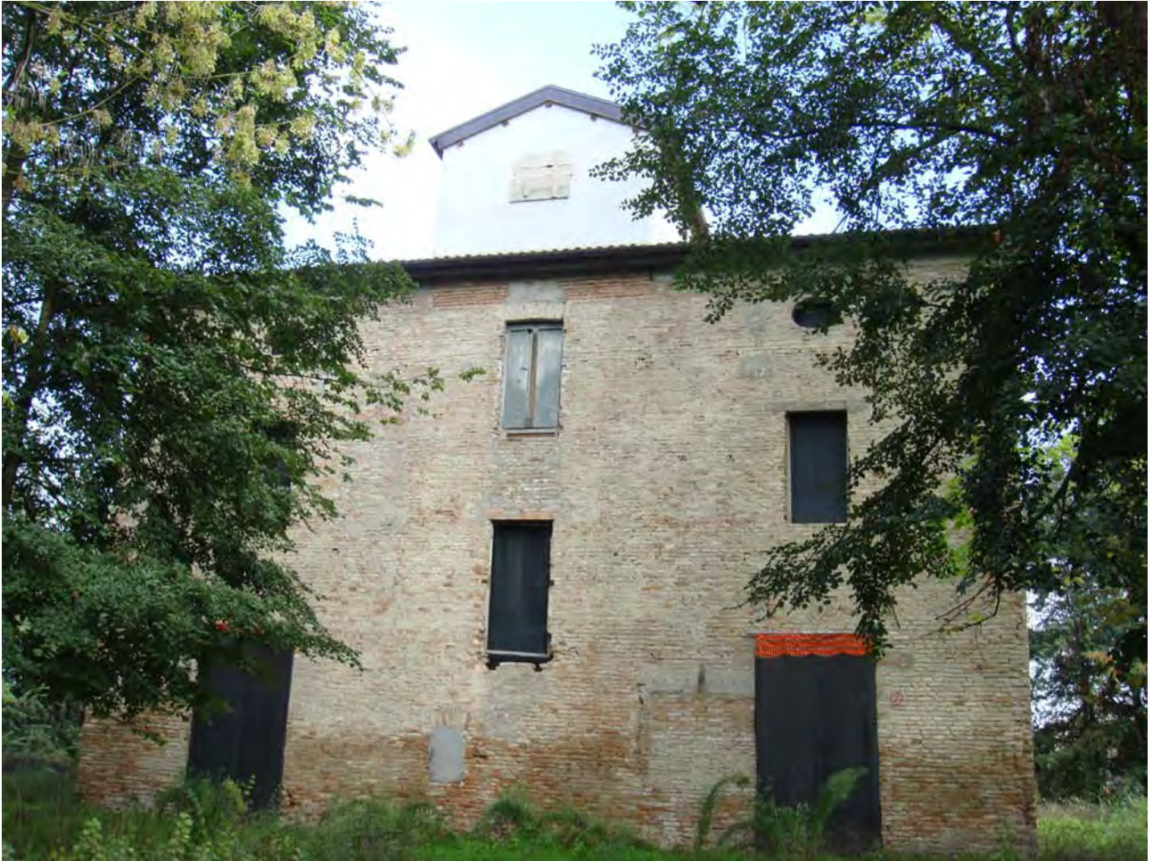
Foto 9. Mapp. 23. Prospetto Sud-Ovest.
