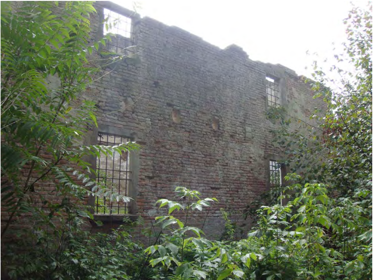
Foto 18. Mapp. 142 (ex mapp. 22). Parte del prospetto Nord-Ovest.
