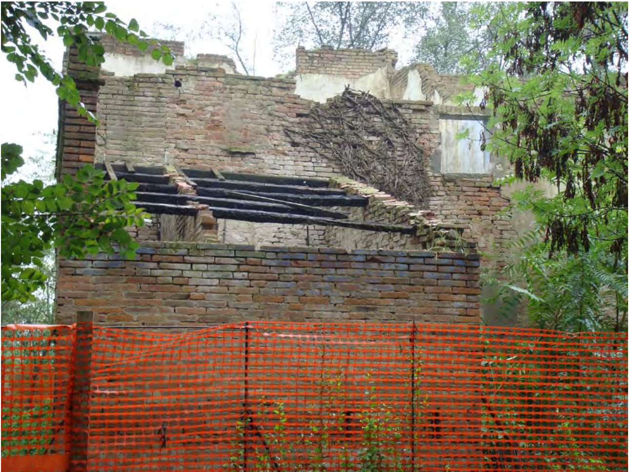
Foto 17. Mapp. 142 (ex mapp. 22). Parte del prospetto Nord-Ovest.
