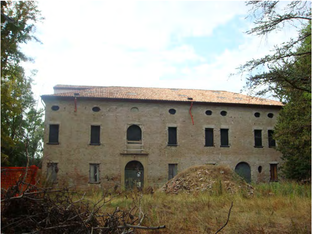
Foto 6. Mapp. 23. Prospetto Sud-Est.
