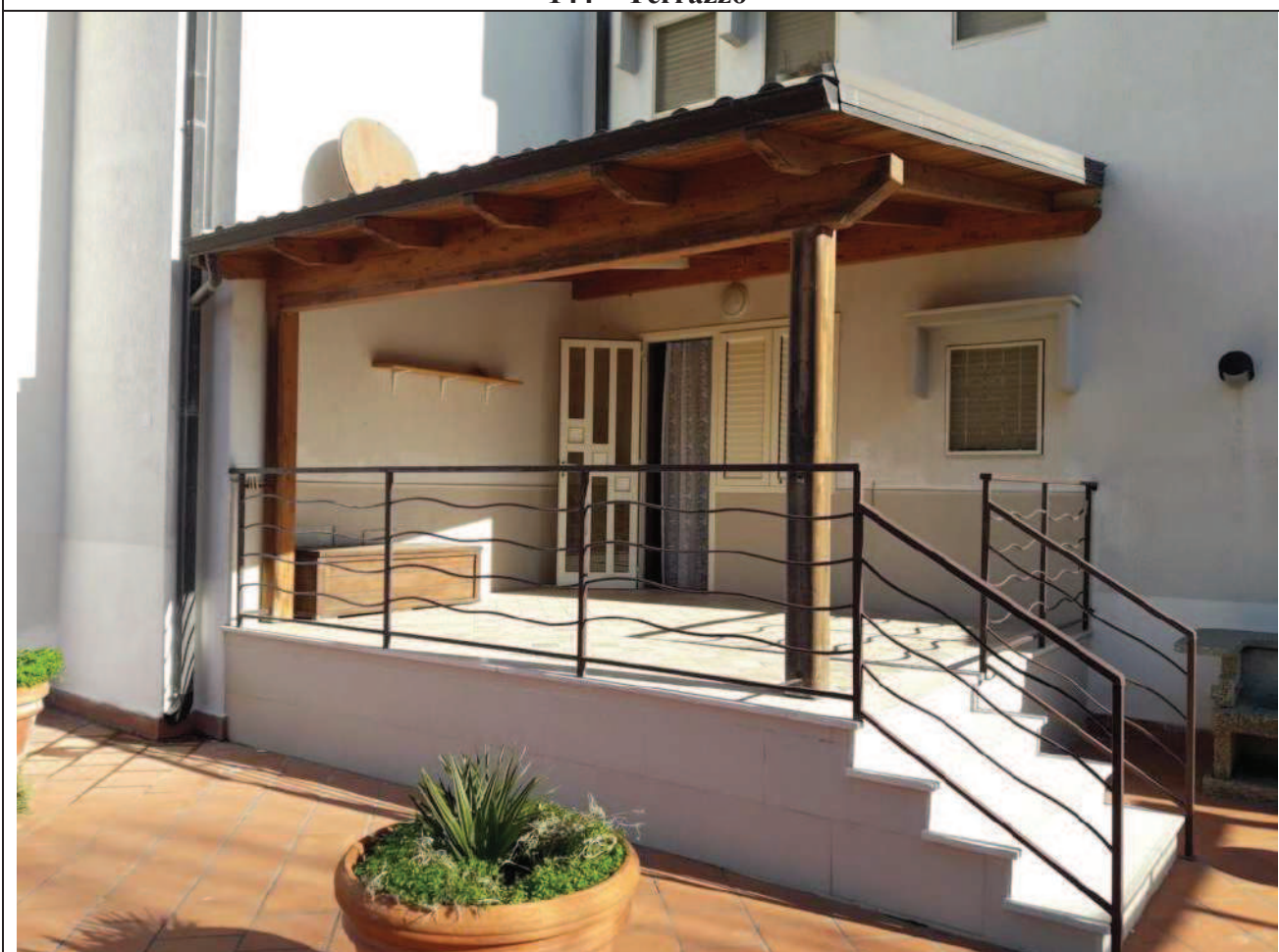
145 – Rampa di scale rialzata più gazebo mai approvato dal Comune di Lesina
