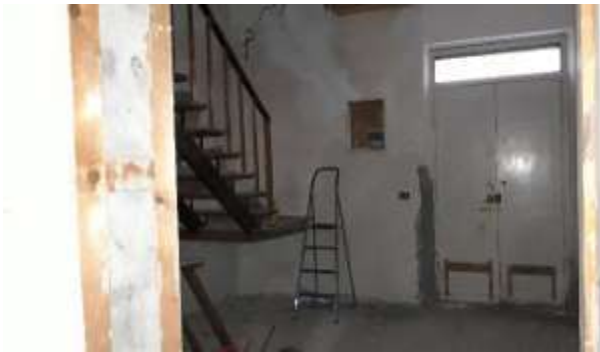
Foto 3: Ingresso da via Matteotti
