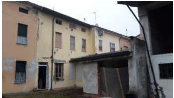
Foto 2: Retro dal cortile
