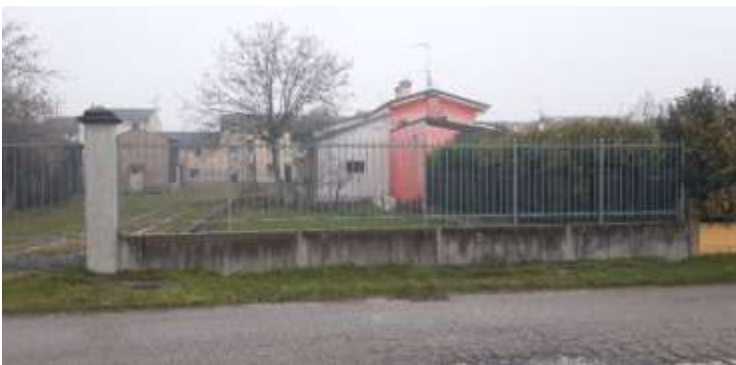
Foto 15: Recinzione via Tartaro Fabrezza
