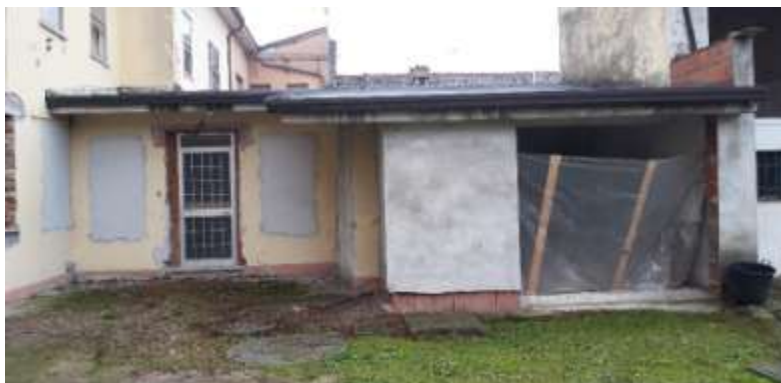
Foto 10: Garage piccolo e retrocucina
