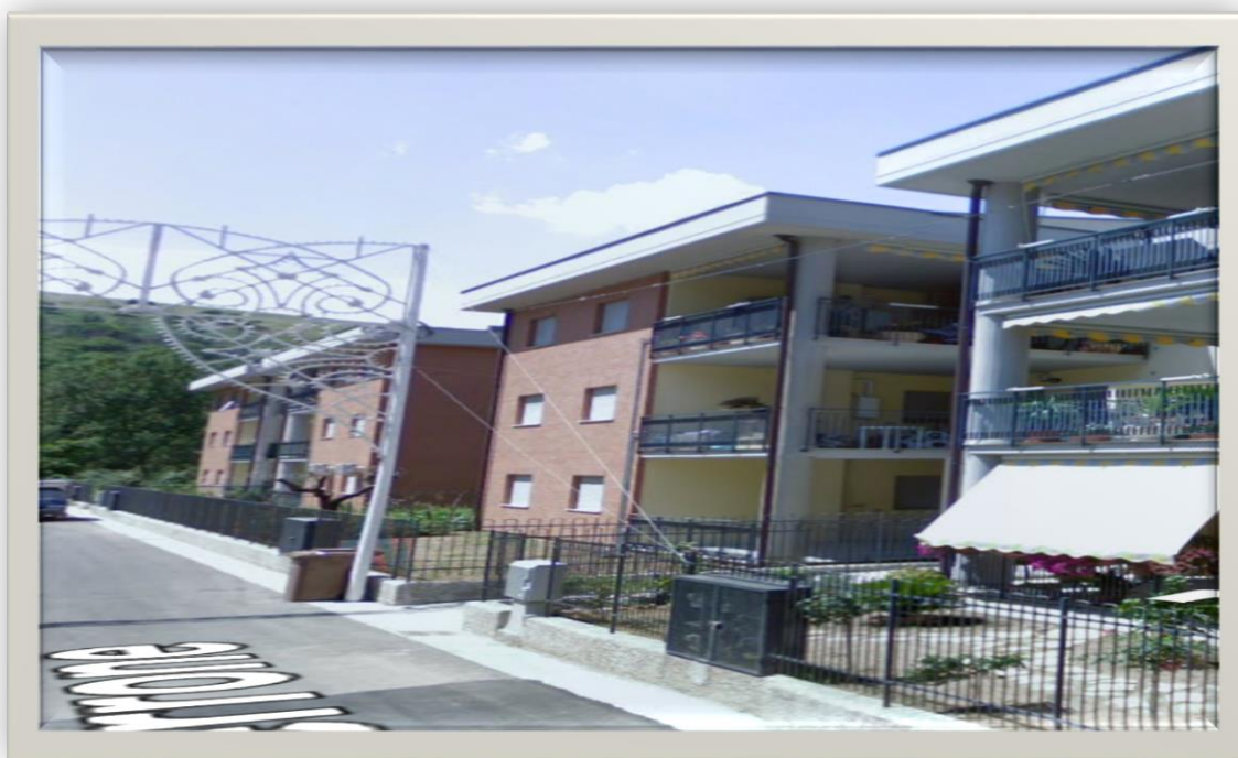
Foto 5a: Accesso al fabbricato "C"
