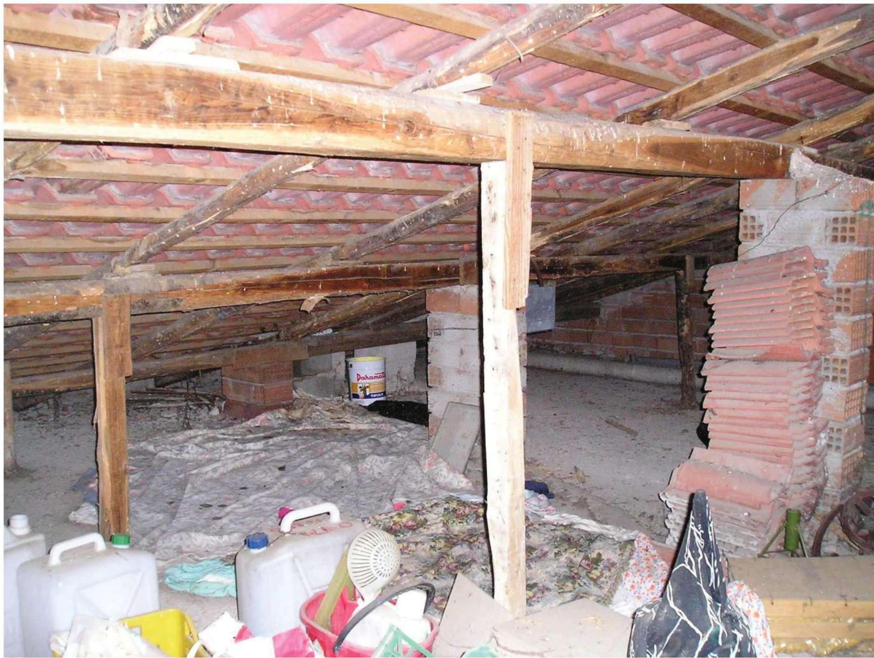
Foto n. 29: immobile 4 – particolare soffitta allo stato rustico
