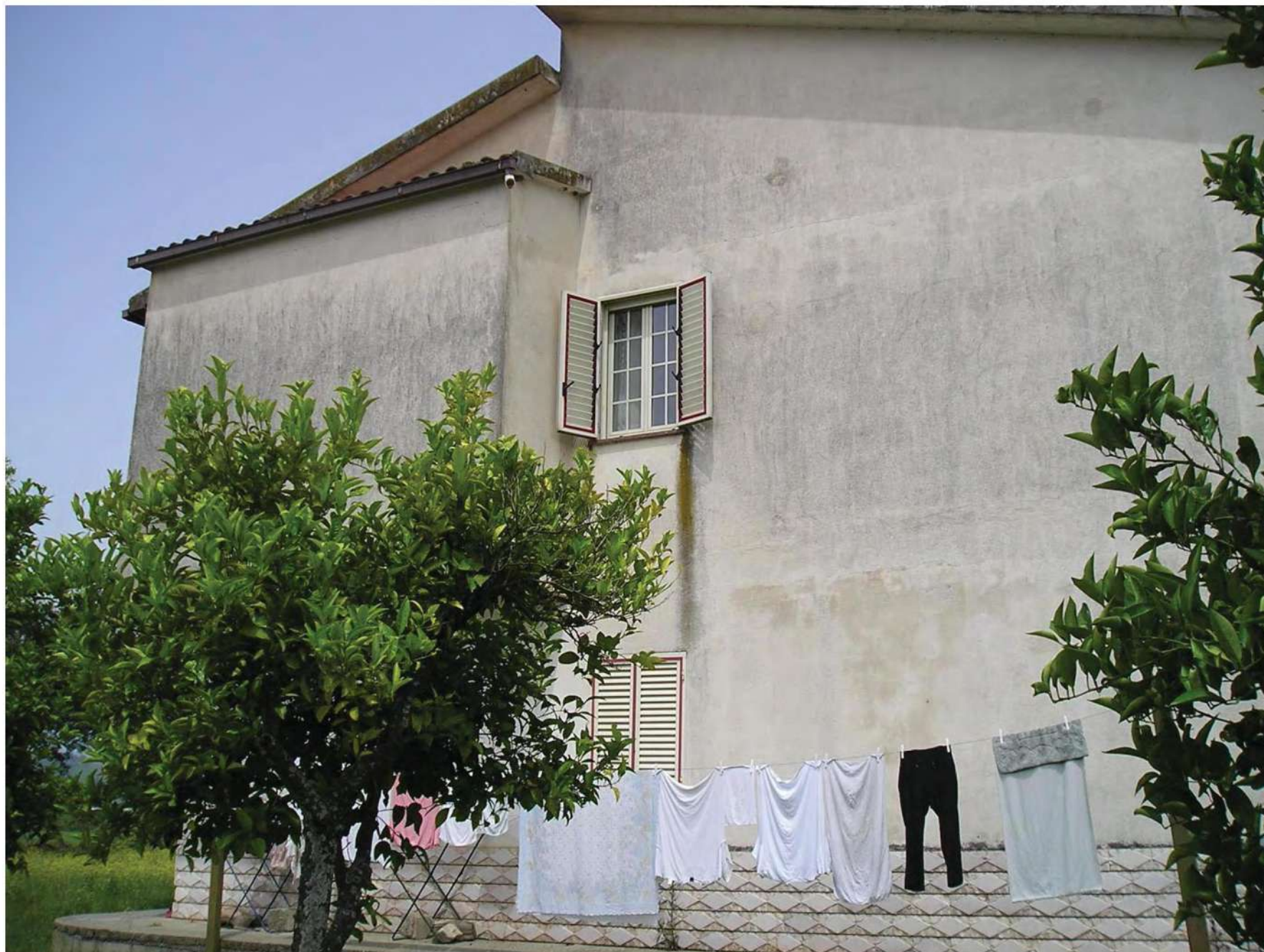
Foto n. 8: fabbricato di cui fanno parte gli immobili 2, 3 e 4
