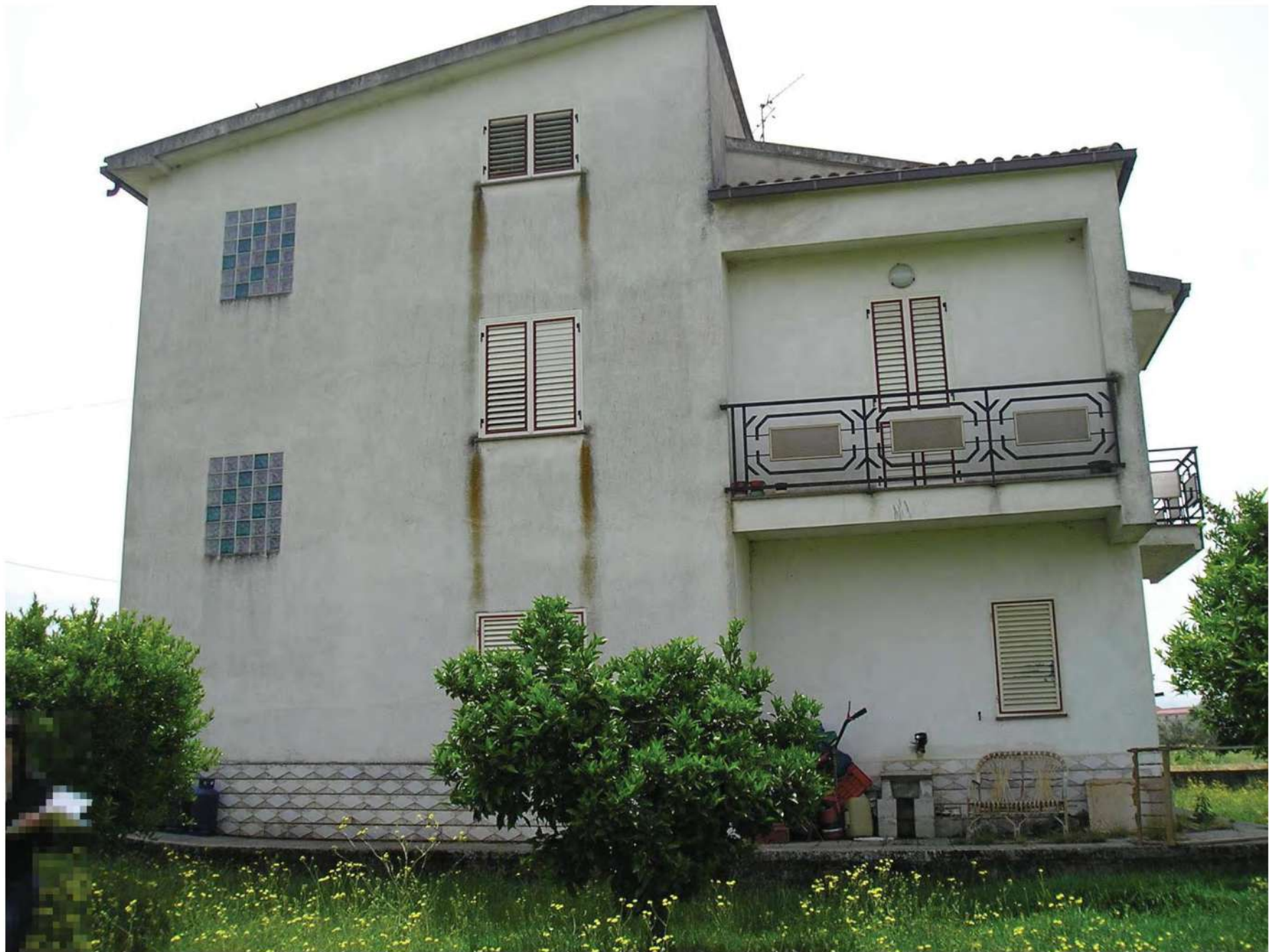
Foto n. 10: fabbricato di cui fanno parte gli immobili 2, 3 e 4
