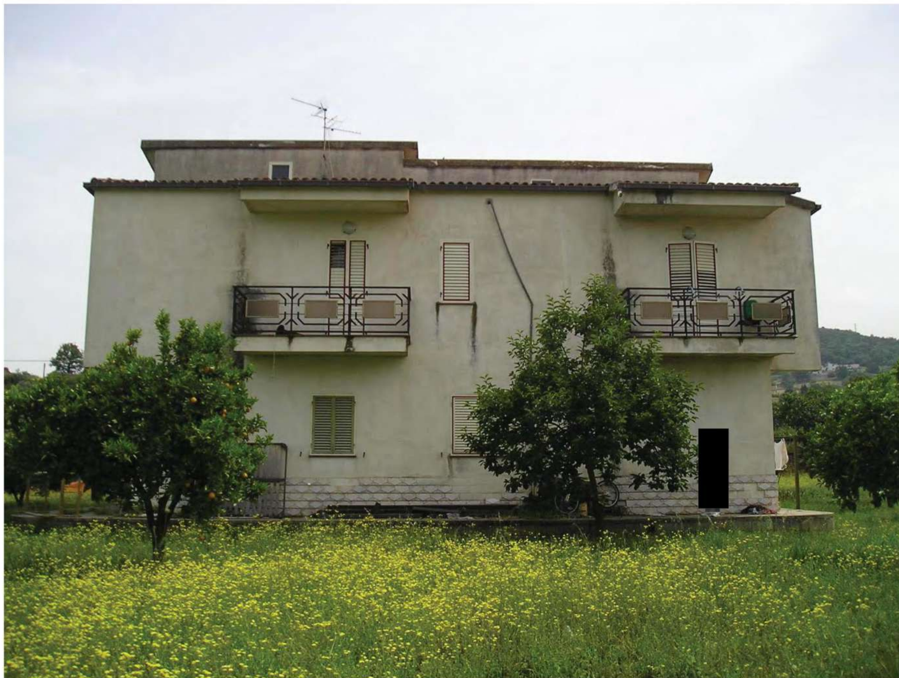
Foto n. 9: fabbricato di cui fanno parte gli immobili 2, 3 e 4
