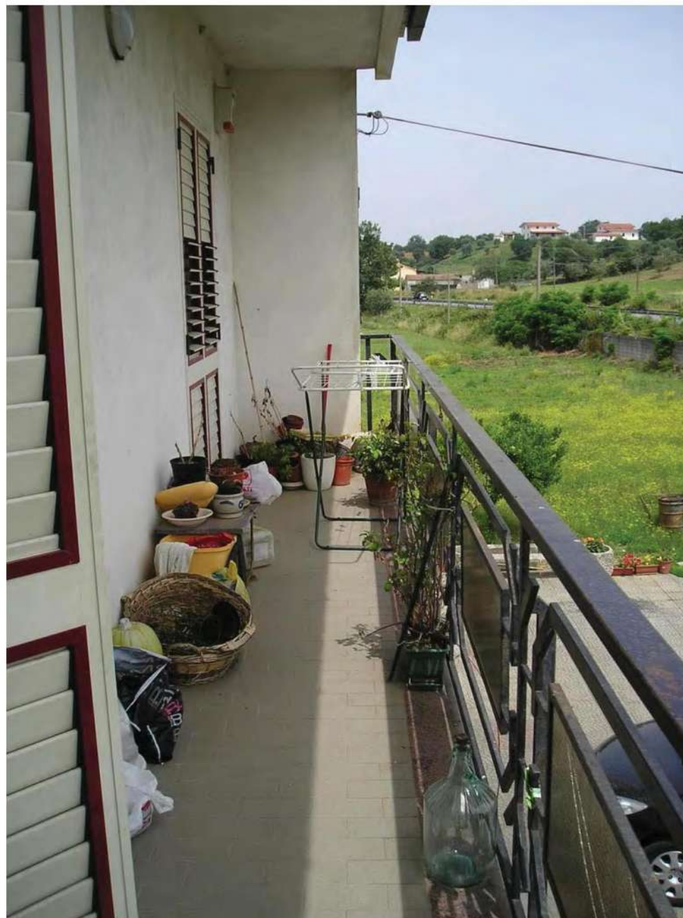
Foto n. 27: immobile 4 – particolare balcone
