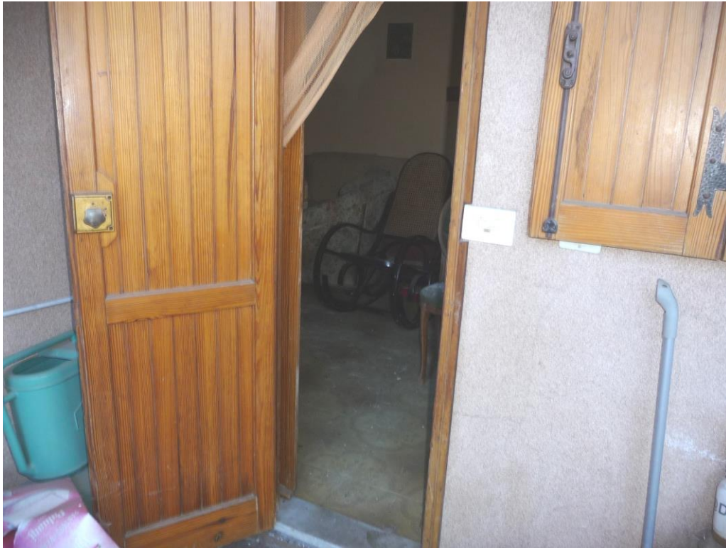
Foto 10 – Ingresso piano primo
