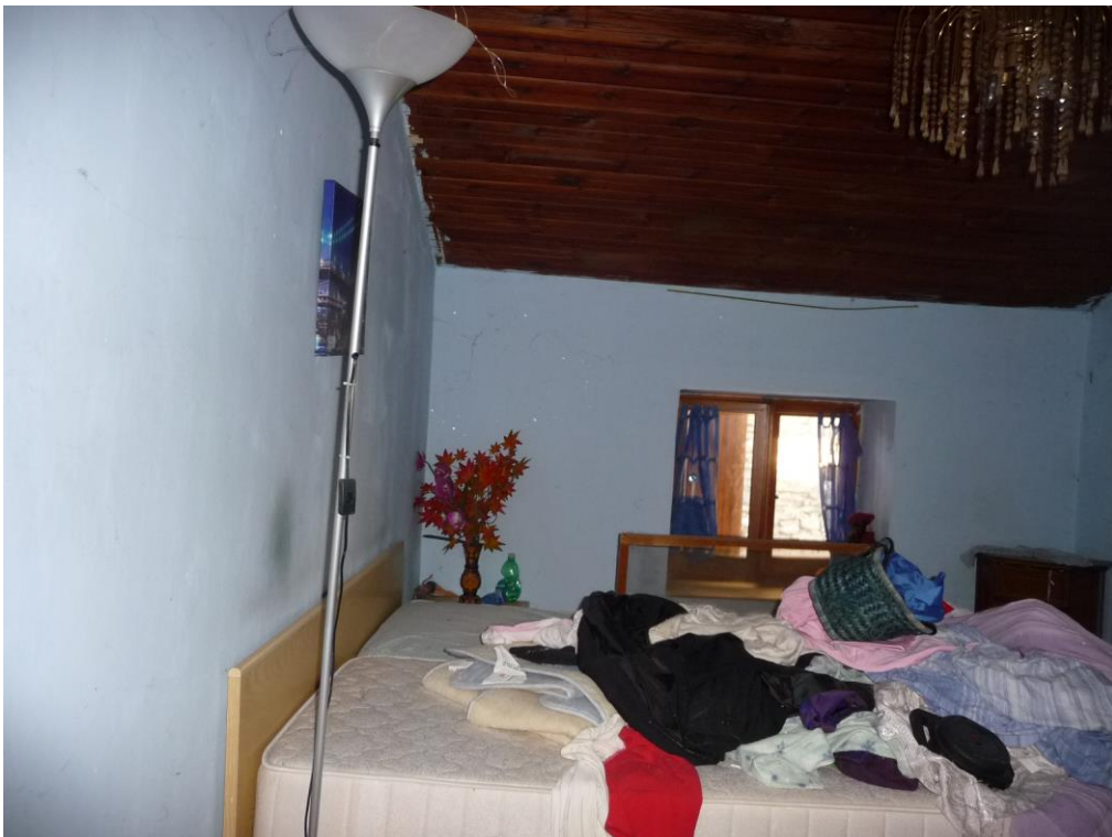
Foto 15 – Camera piano primo
