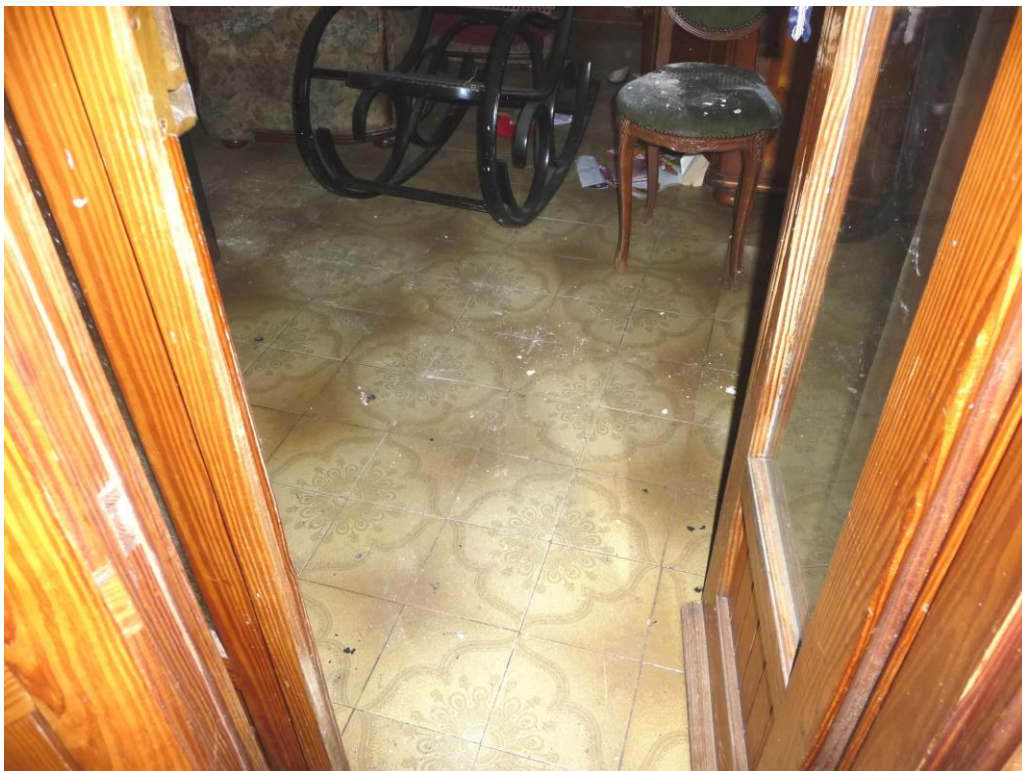
Foto 11 – Interno piano primo
