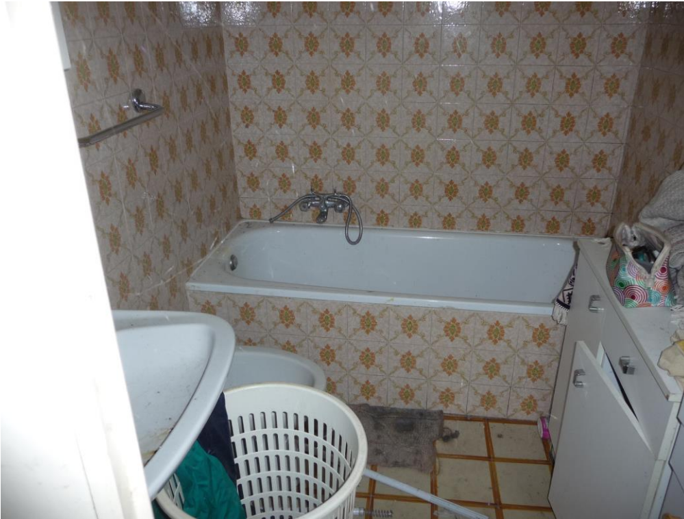
Foto 8 – Bagno al piano terra
