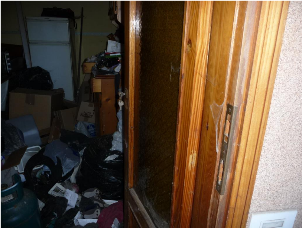
Foto 6 – Piano terra rialzato
