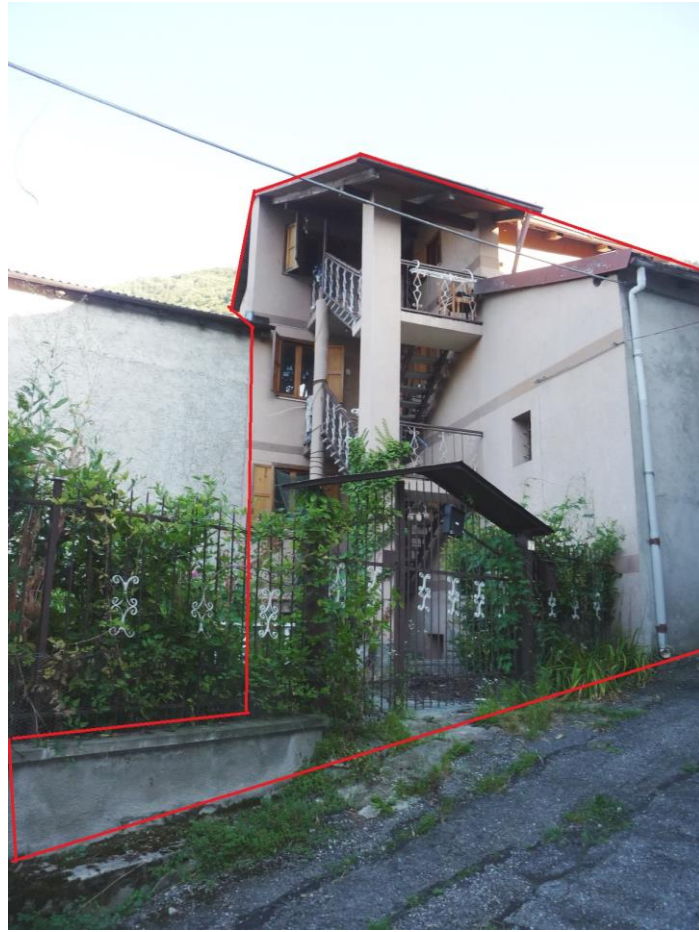
Foto 2 – Ingresso e casa
