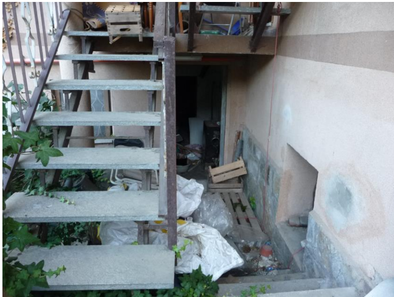
Foto 3 – Ingresso al seminterrato e scala esterna
