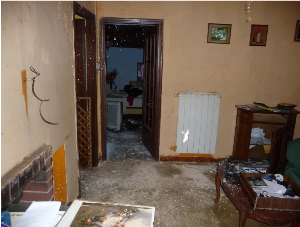
Foto 12 – Interno piano primo
