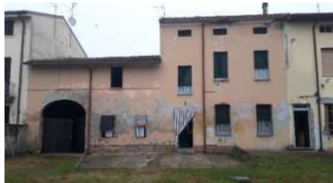
Foto 2: Retro dal cortile
