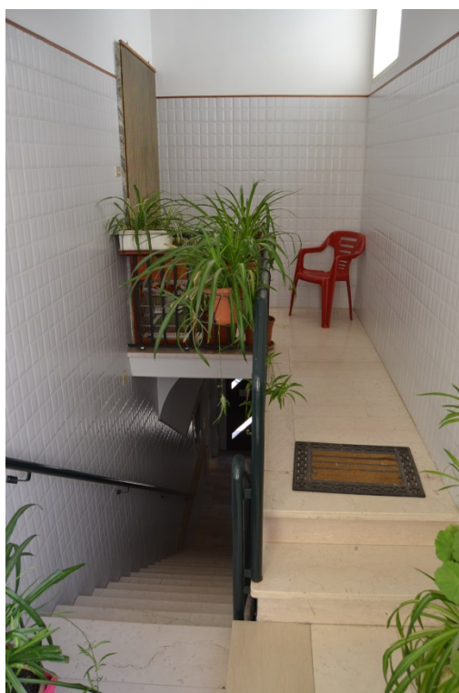
FOTO N.04 – VISTA BALLATOIO ACCESSO ESCLUSIVO
