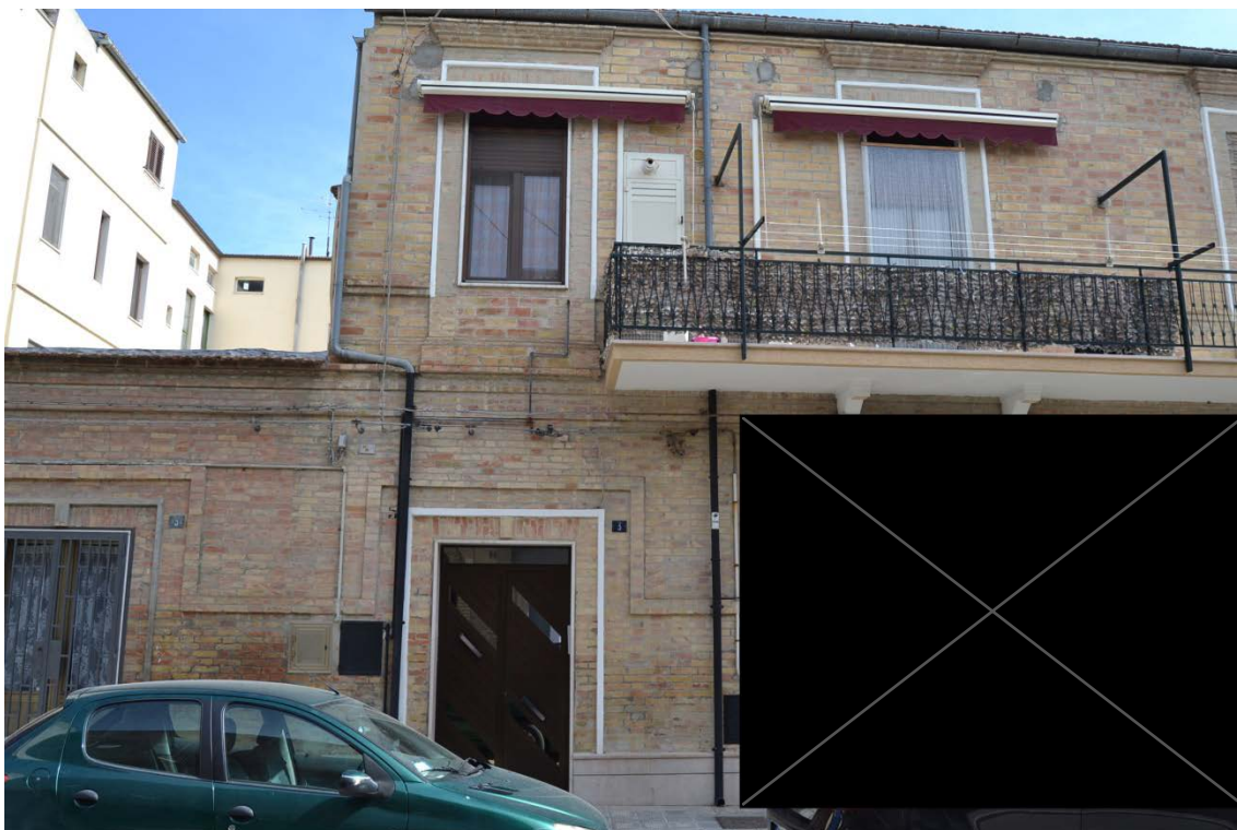
FOTO N.01 – PROSPETTO SU VIA CAVOUR
