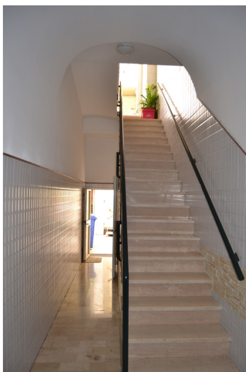
FOTO N.03 – VISTA SCALA DI ACCESSO COMUNE
