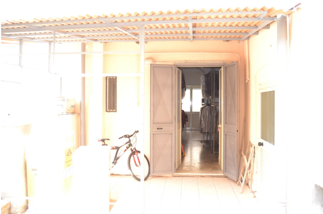
FOTO N.02 – PROSPETTO SU CORTILE INTERNO
