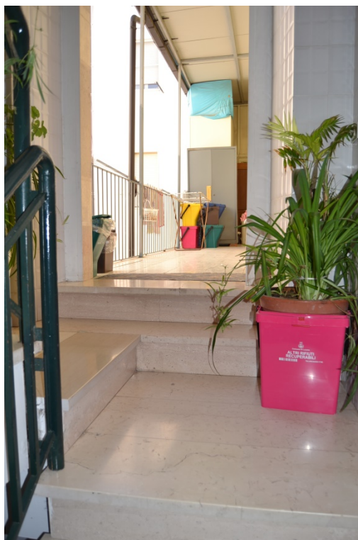
FOTO N.03 – VISTA SCALA DI ACCESSO COMUNE
