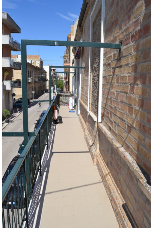
FOTO N.05 – VISTA ESTERNA BALCONE
