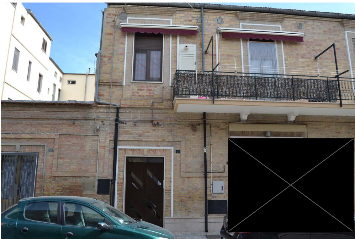
FOTO N.01 – PROSPETTO SU VIA CAVOUR
