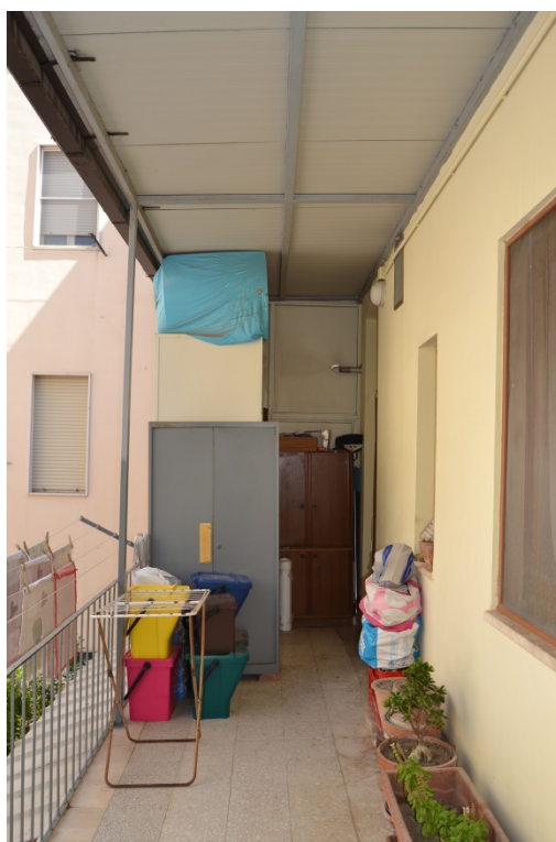
FOTO N.04 – VISTA BALLATOIO ACCESSO COMUNE
