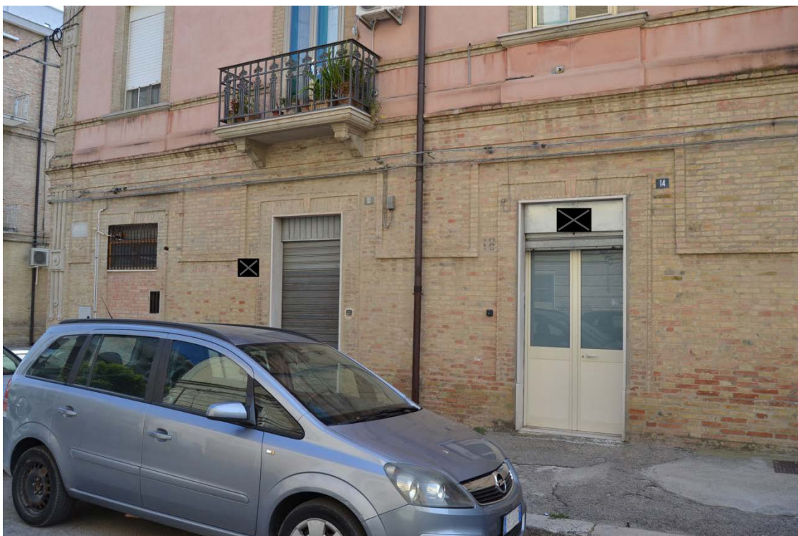
FOTO N.01 – PROSPETTO SU VIA TORINO
