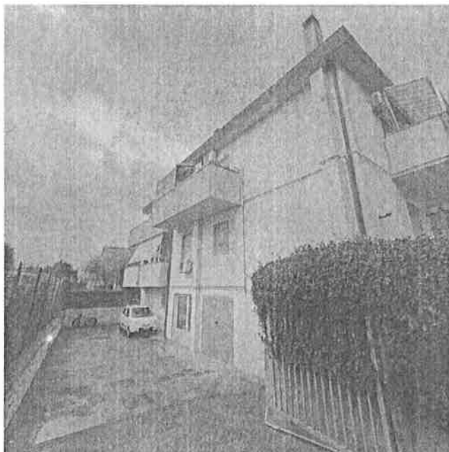
Foto n. 4 - Fabbricato lato Est
