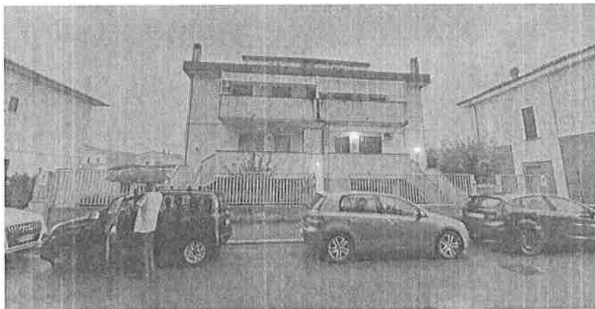
Foto n. 2 - Fabbricato lato Nord
