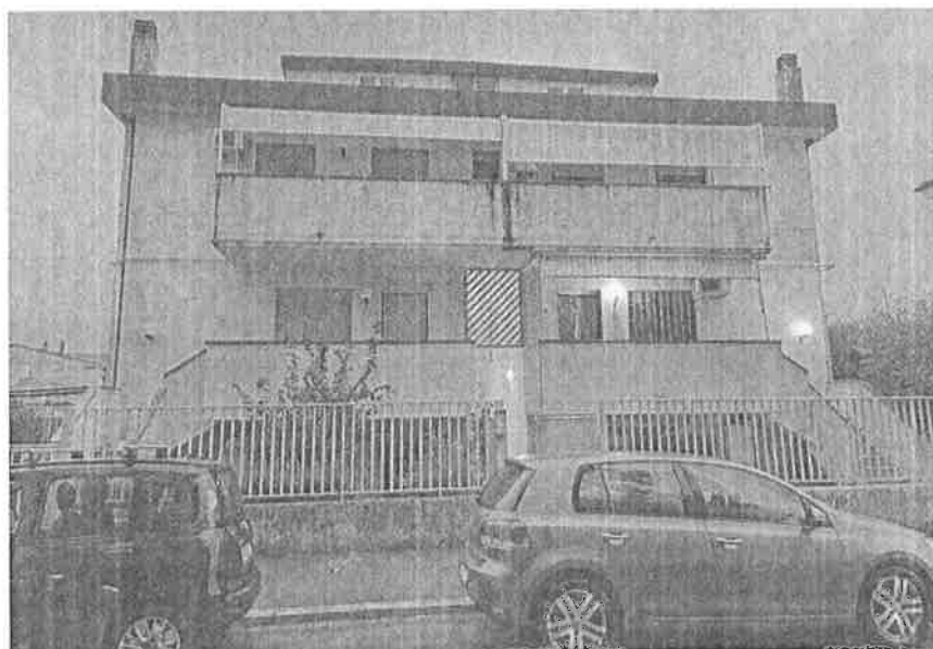
Foto n. 3 - Fabbricato lato Nord
