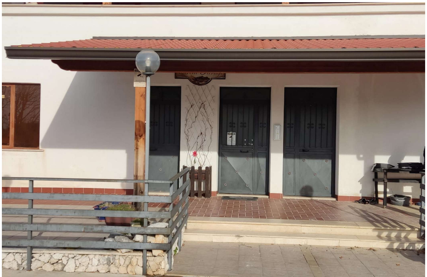
Foto n.3 – Vista ingresso condominiale lato sud maggior fabbricato mapp. 310
