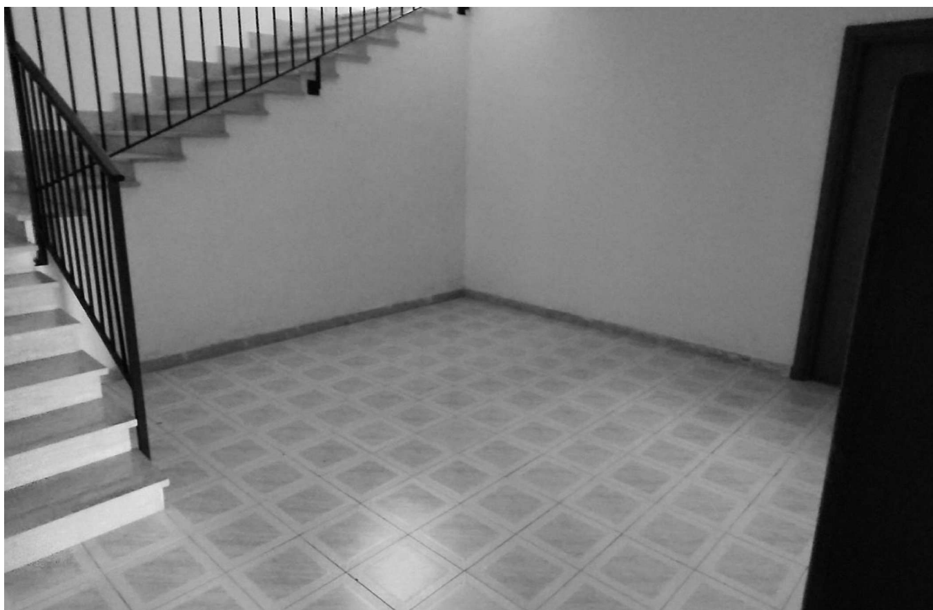
Foto n.10 – Vista scala condominiale fabbricato fgl.9 mapp.310 sub.21
