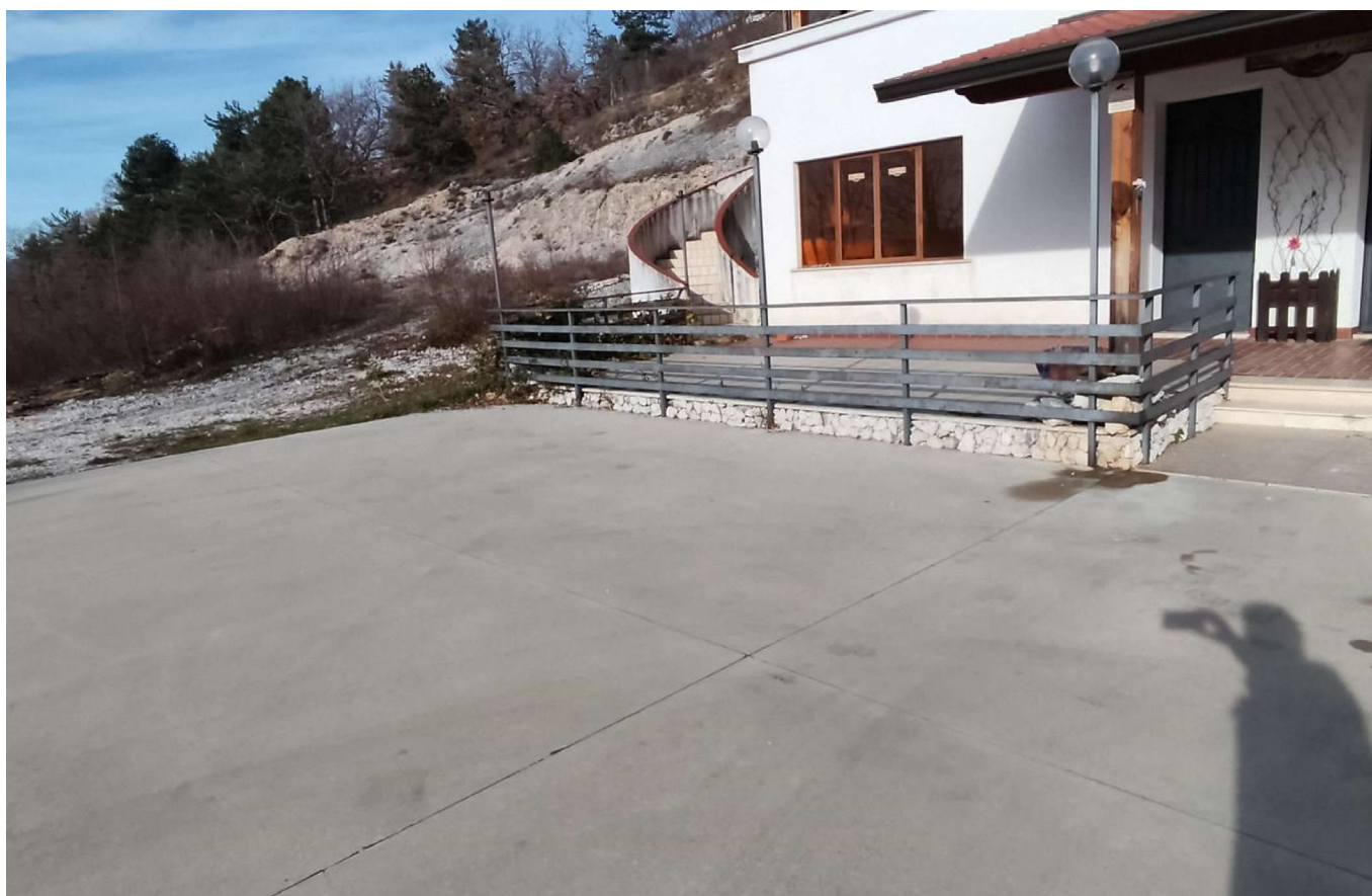
Foto n.16 – Vista zona posto auto bene fgl.9 mapp.310 sub.21
