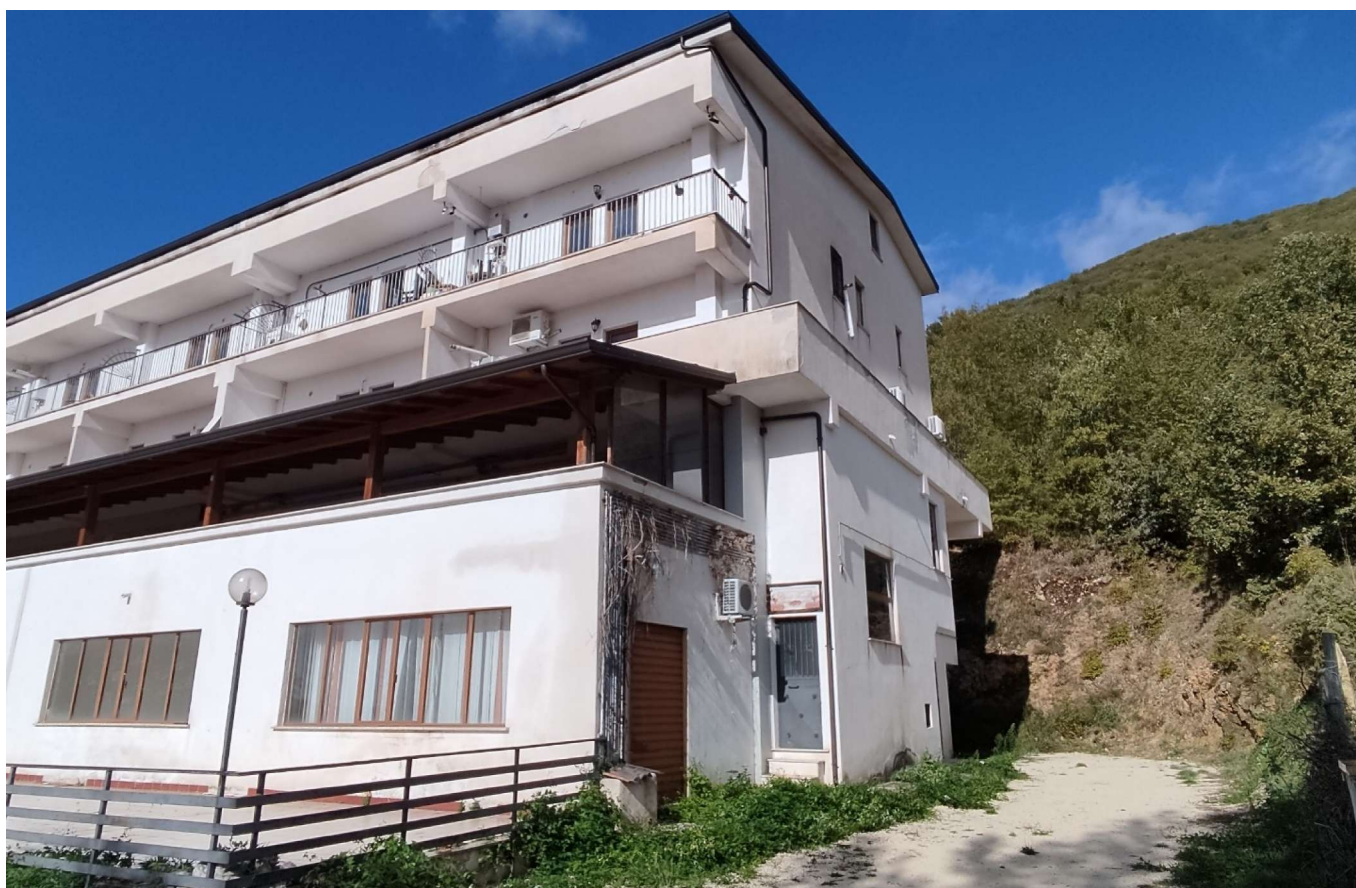
Foto n.6 – Vista lato est maggior fabbricato mapp. 310
