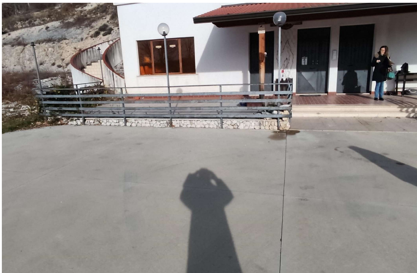
Foto n.17 – Vista zona posto auto bene fgl.9 mapp.310 sub.21
