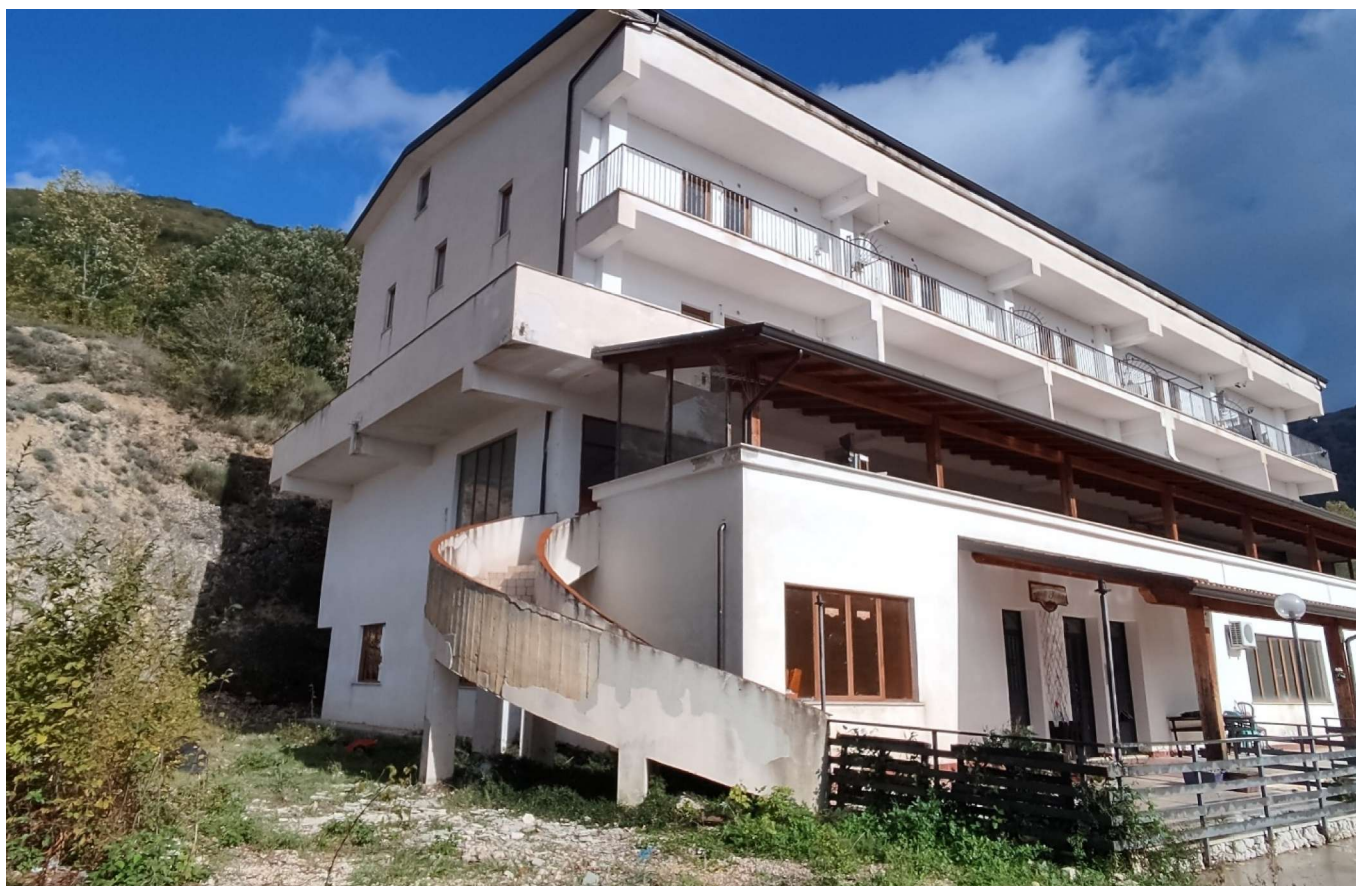
Foto n.5 – Vista lato ovest maggior fabbricato mapp. 310
