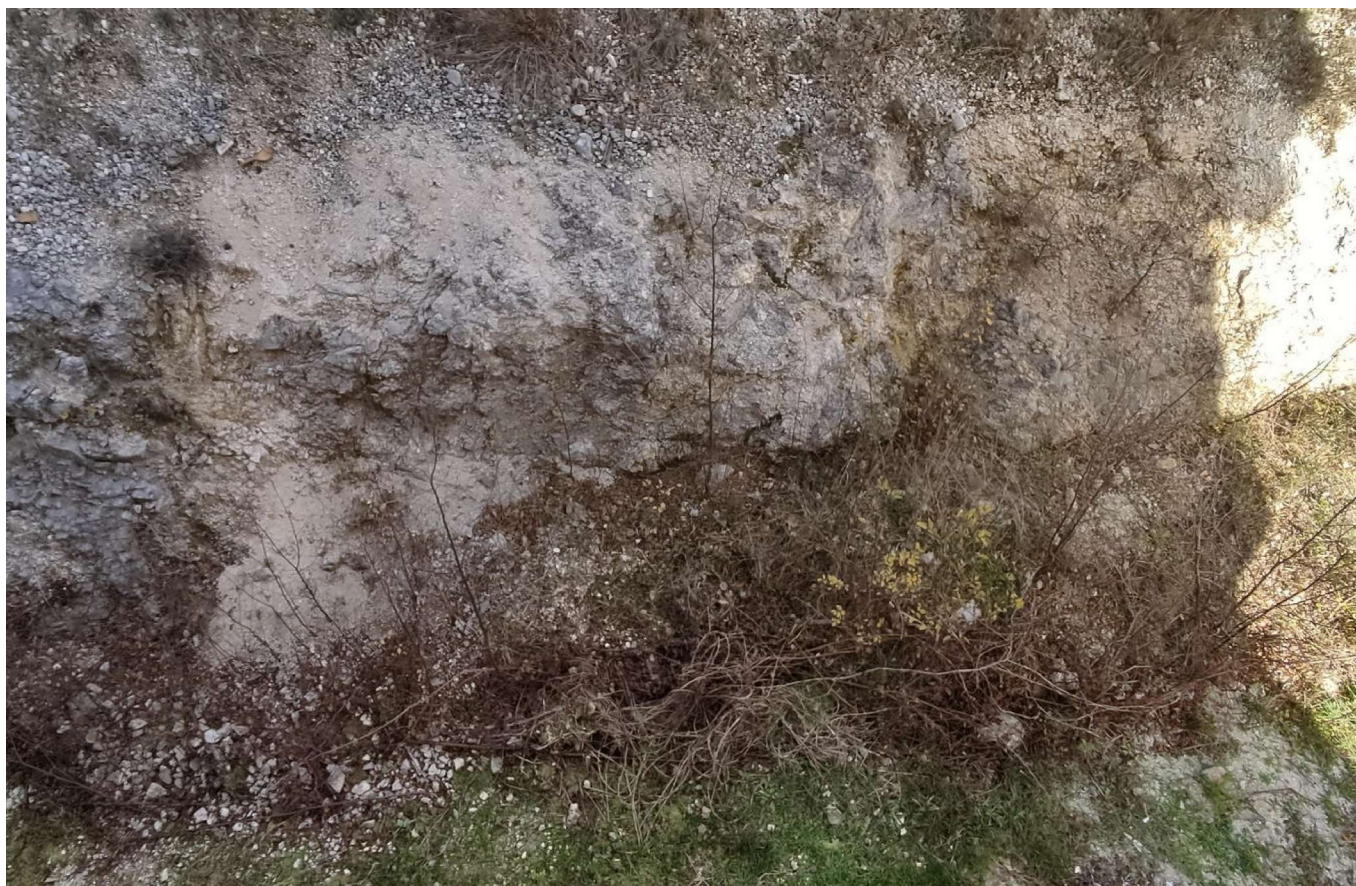
Foto n.8 – Vista terreno lato nord maggior fabbricato mapp. 310
