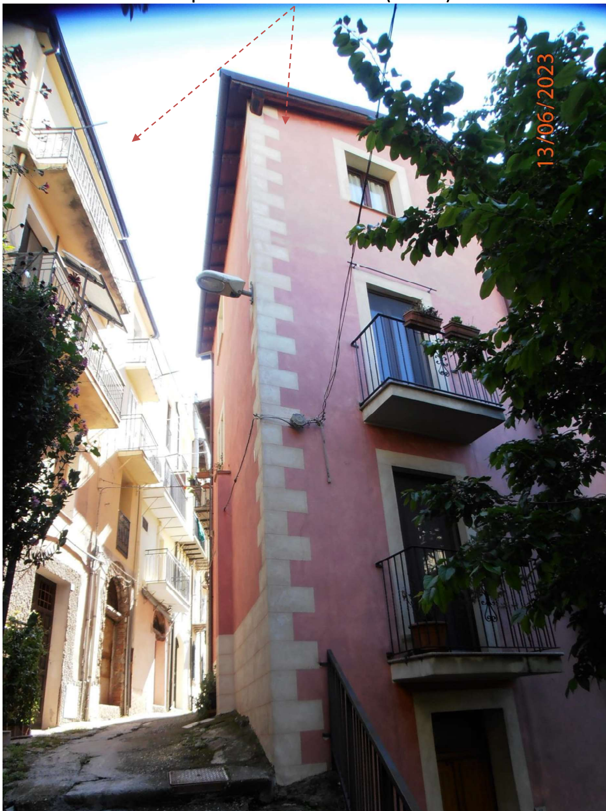
Prospetto esterno del fabbricato (lato Sud)
