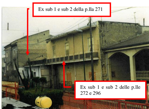
Figura 10 Fabbricati demoliti che costituiscono le particella 271, 272 e 296 con i sub 1 e 2
