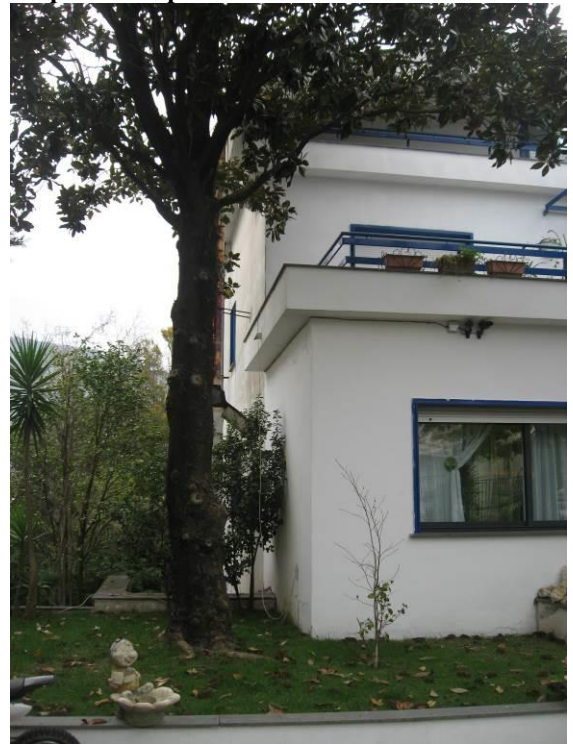
Figura 60 parte dell'immobile 1 costruito sulla p.lla 352 - 20/11/2015
