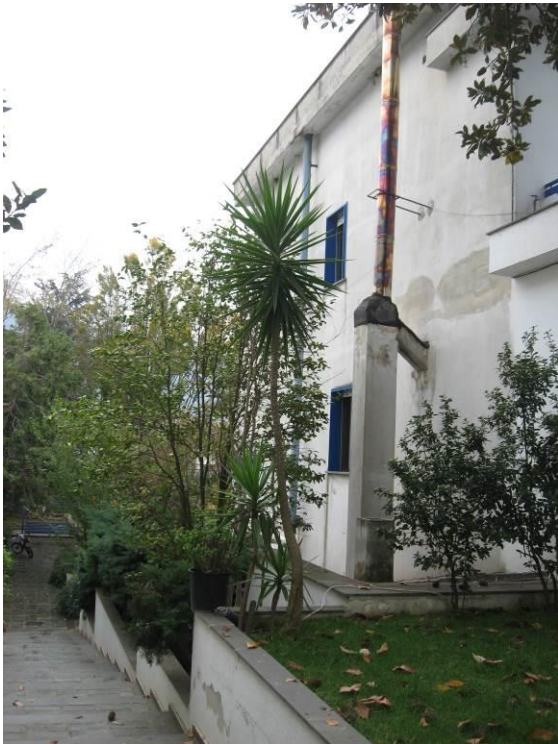
Figura 59 prospetto laterale dell'immobile 1 - 20/11/2015
