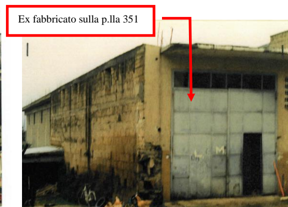
Figura 11 Fabbricato demolito che insisteva sulla particella 351
