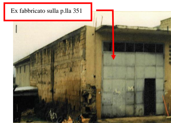
Figura 11 Fabbricato demolito che insisteva sulla particella 351
