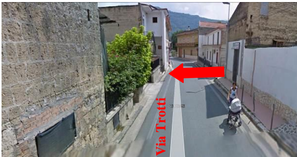
Figura 35 Accesso al fabbricato 6 costituito dalla p.lla 178 sub 2 da via Trotti
