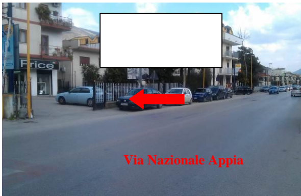
Figura 17 Localizzazione del fabbricato 2 – 14/01/13
