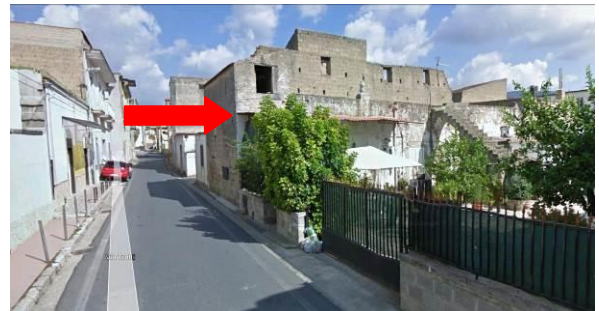
Figura 32 Facciata del fabbricato 5 costituito dalla p.lla 169 sub 2, prospiciente via Trotti
