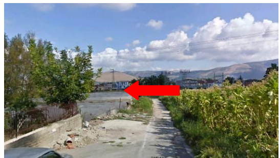
Figura 24 Lato della p.lla 230 del foglio 4 che costituisce l'immobile 3, prospiciente via Manzoni
