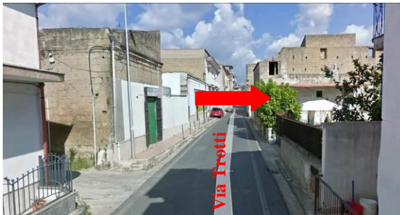
Figura 31 Accesso al fabbricato 5 costituito dalla p.lla 169 sub 2 da via Trotti
