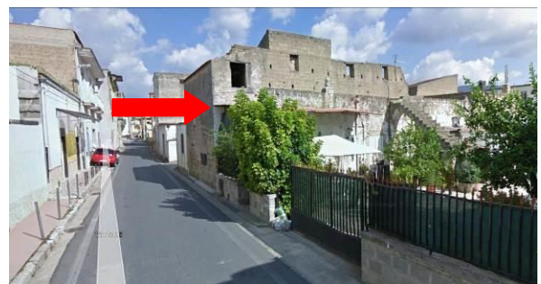
Figura 28 Facciata del fabbricato 4 costituito dalla p.lla 169 sub 1, prospiciente via Trotti
