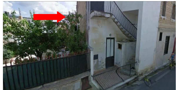
Figura 36 Facciata del fabbricato 6 costituito dalla p.lla 178 sub 2, prospiciente il cortile interno
