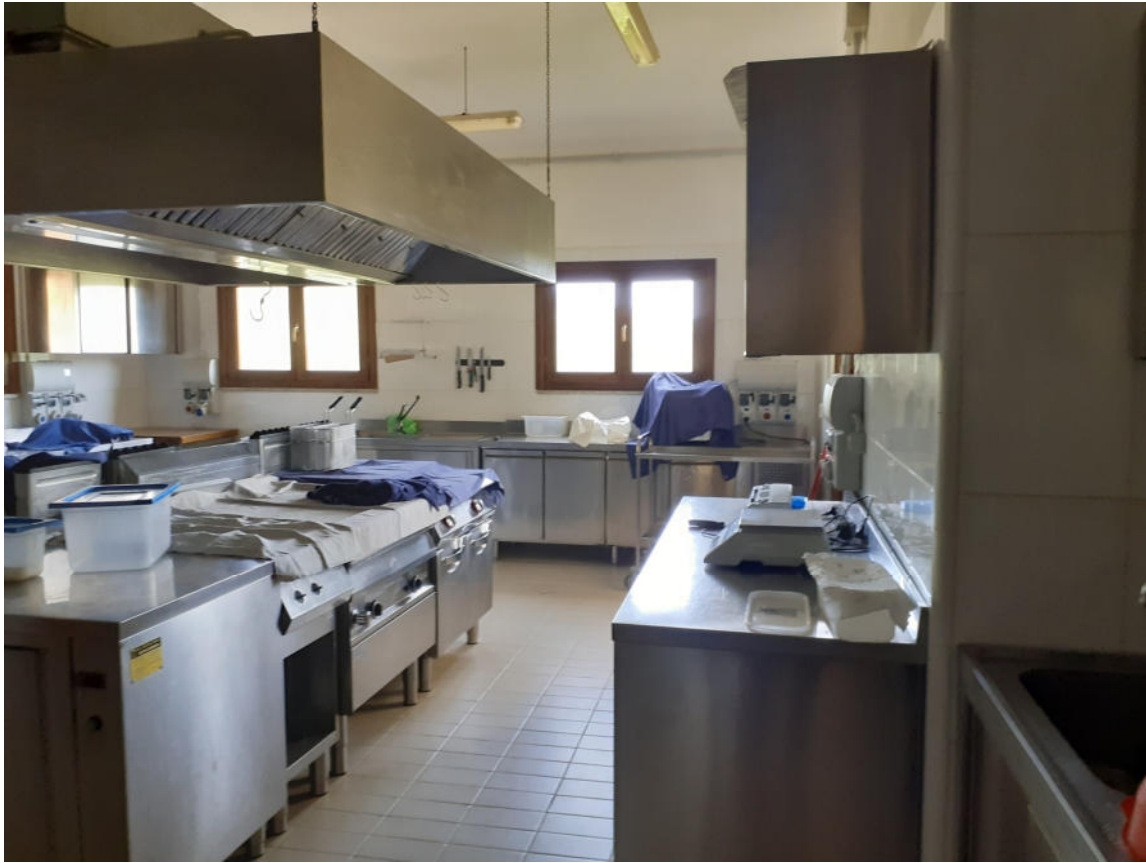
Fotografia 25 — Edificio A — Cucina — Interni
