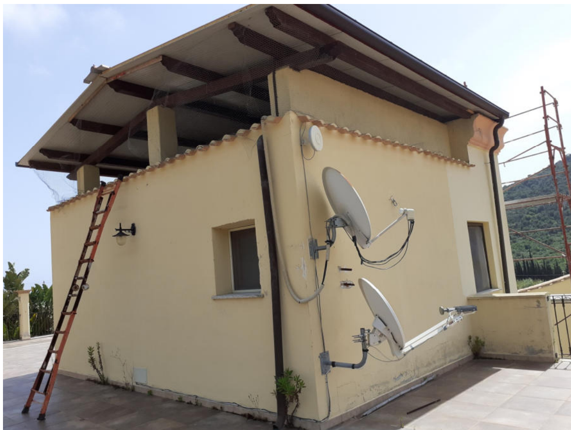
Fotografia 31 — Edificio A — Direzione — Esterni
