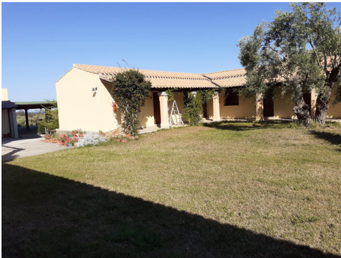
Fotografia 3 — Edificio A — Camere piano terra—Vista
