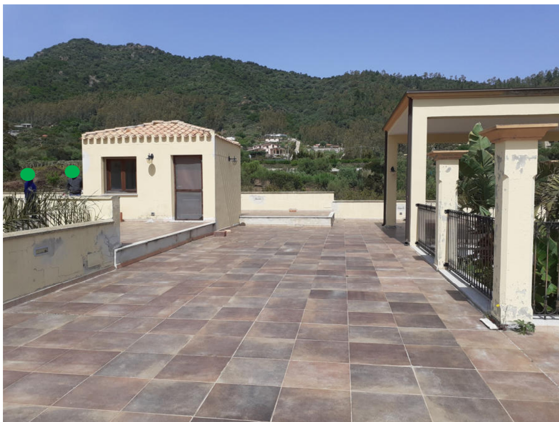
Fotografia 33 — Edificio A — Lastrico solare
