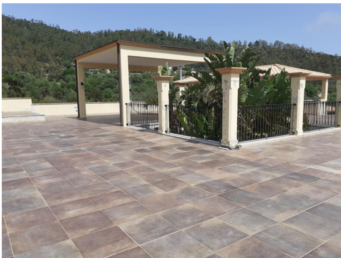
Fotografia 34 — Edificio A — Lastrico solare
