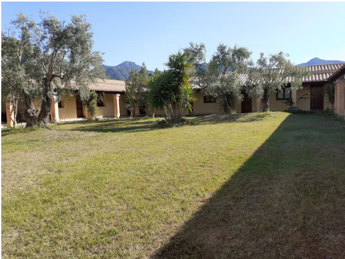
Fotografia 2 — Edificio A — Camere piano terra—Vista
