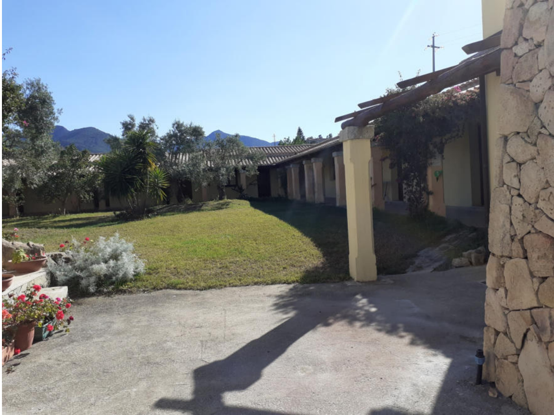
Fotografia 1 — Edificio A — Camere piano terra—Vista
