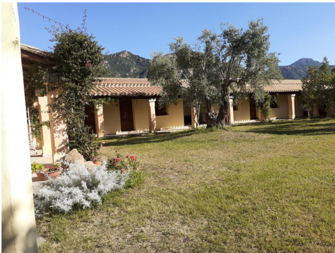
Fotografia 4 — Edificio A — Camere piano terra—Vista
