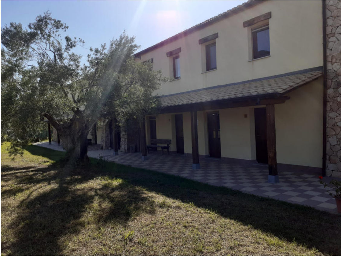
Fotografia 7 — Edificio A — Camere piano seminterrato — Vista
