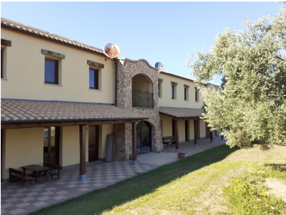
Fotografia 8 — Edificio A — Camere piano seminterrato — Vista
