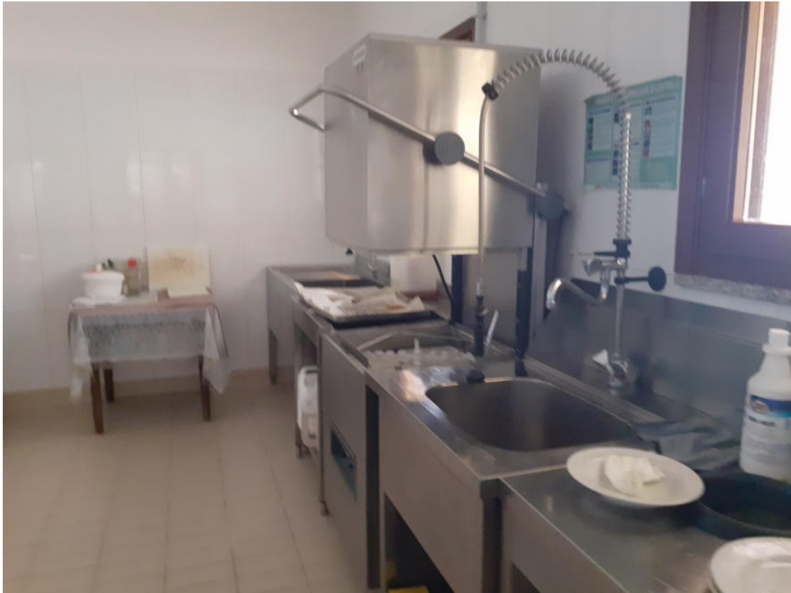
Fotografia 27 — Edificio A — Lavaggio — Interni
