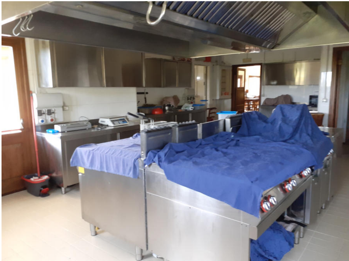
Fotografia 26 — Edificio A — Cucina — Interni
