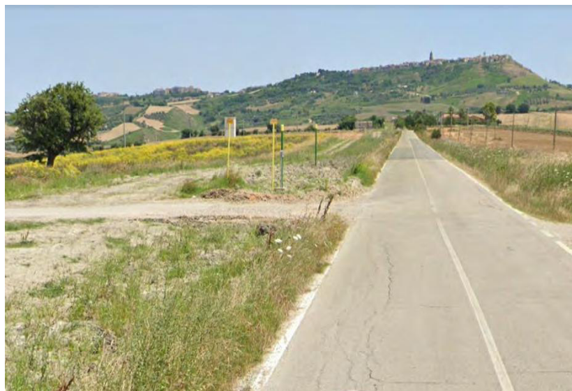
FOTO N.04 Strada Statale 483 e innesto con via Carriera di Rivera
