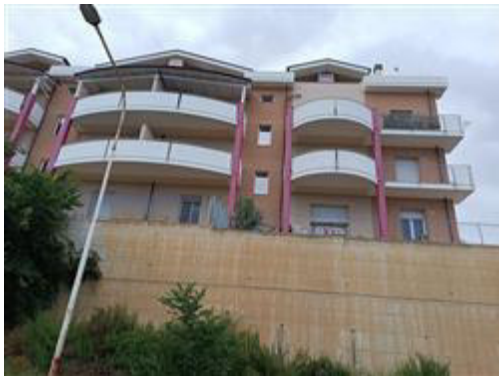
Vista esterna edificio
