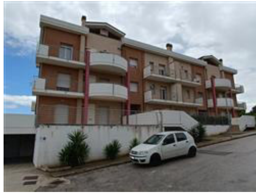
Vista esterna edificio
