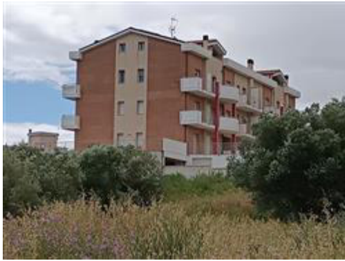
Vista esterna edificio
