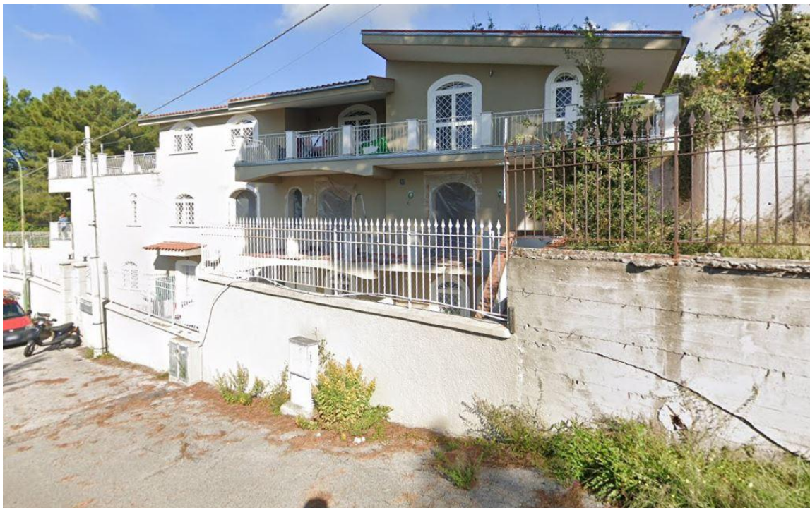
fabbricato principale - prospetto su Via Viulo
