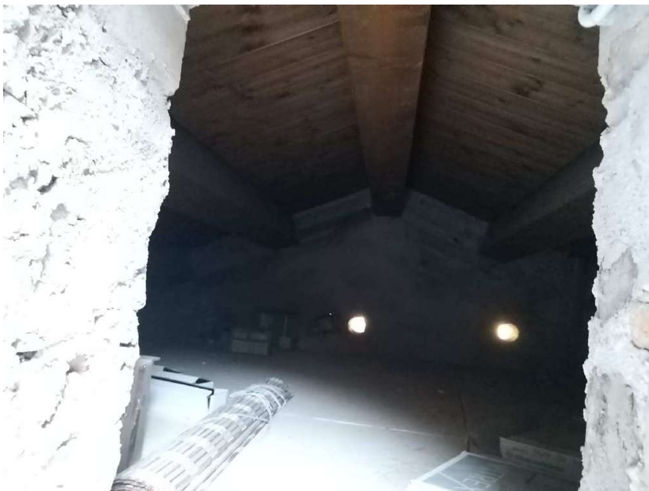
SOFFITTA – PIANO SECONDO
