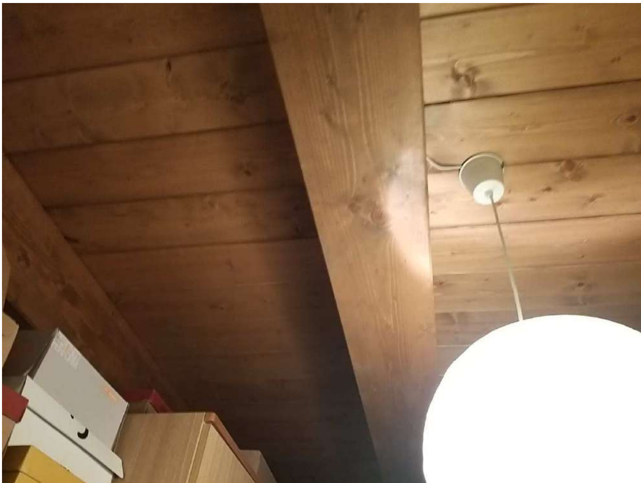
SOFFITTO DEL SOTTOTETTO CON TRAVI DI LEGNO LAMELLARI E TAVOLATO
