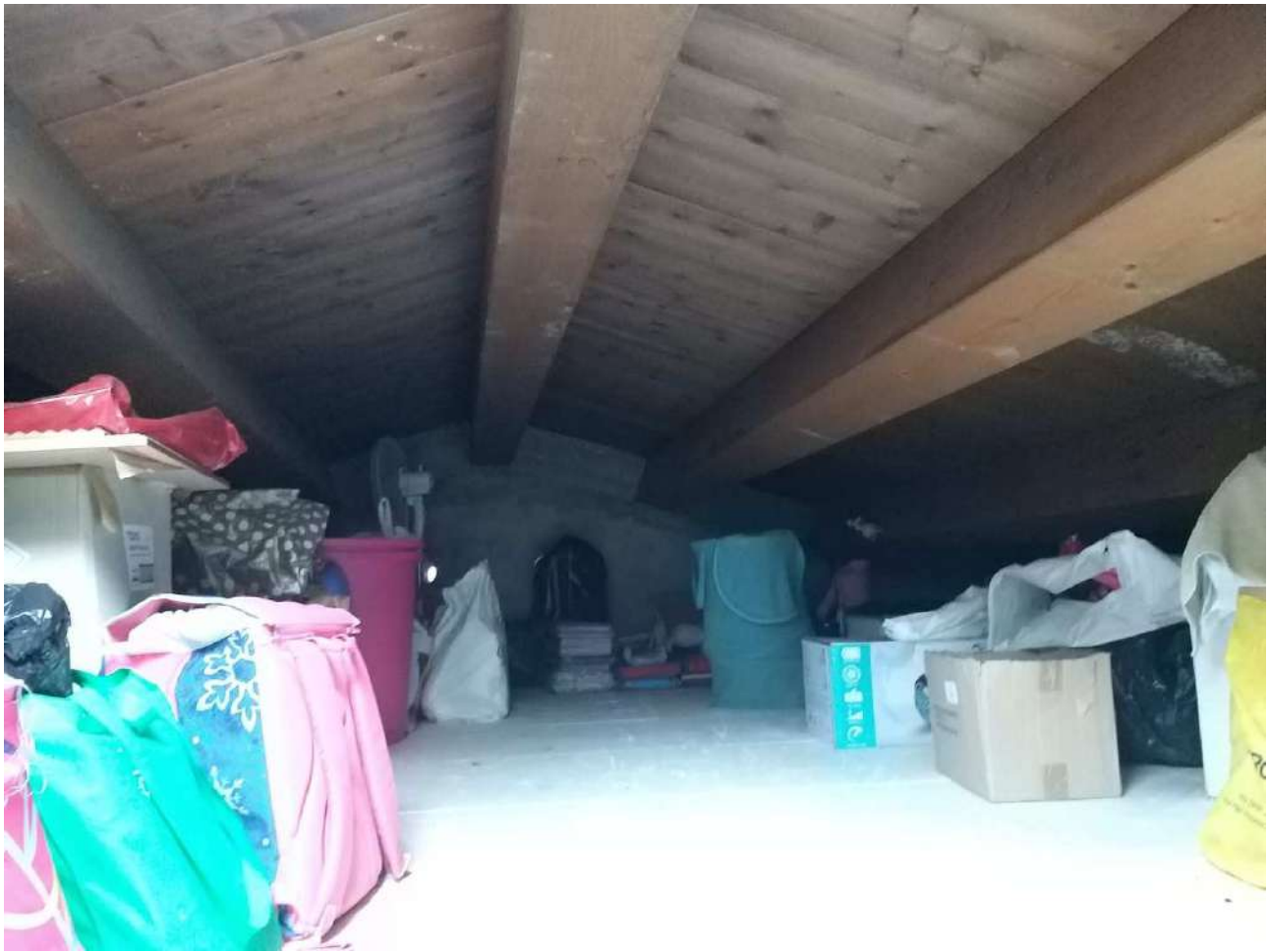
SOFFITTA – PIANO SECONDO
