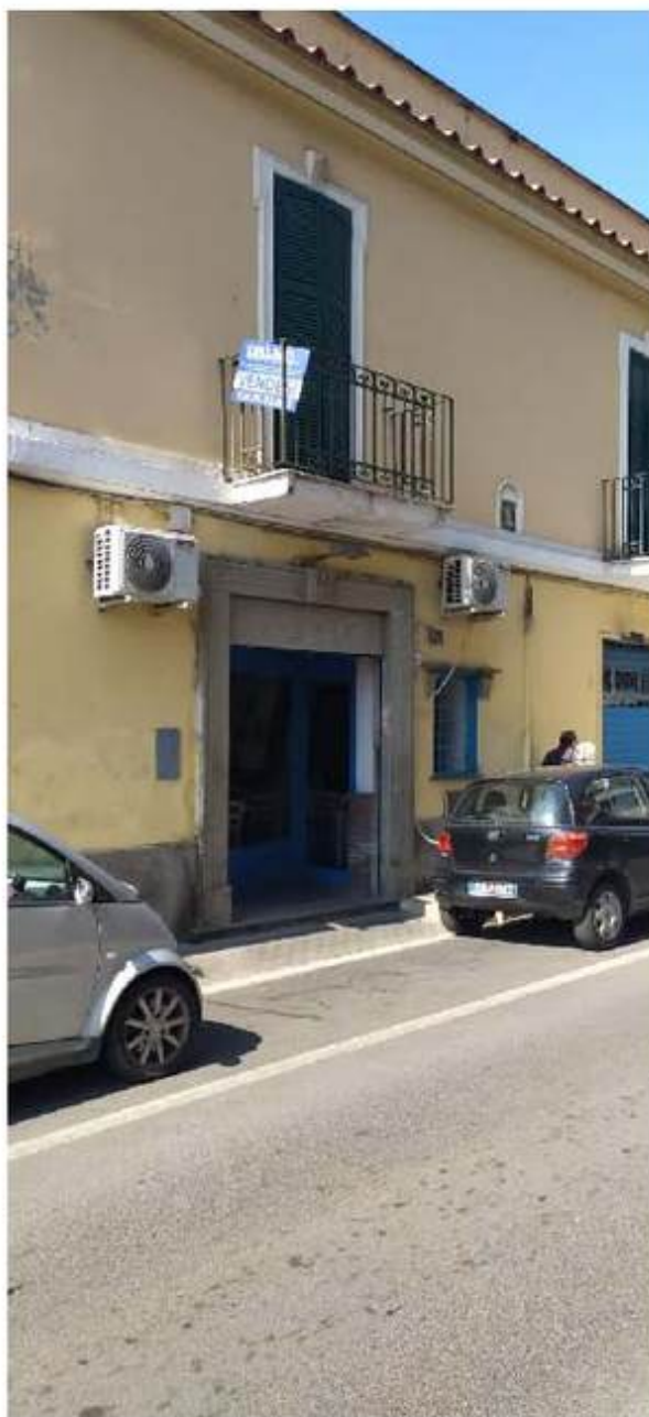
FOTO 9. Vista dell'entrata al negozio oggetto di perizia
