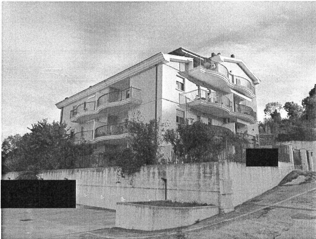
Vista esterna nord-ovest con evidenziato l'appartamento oggetto di stima
