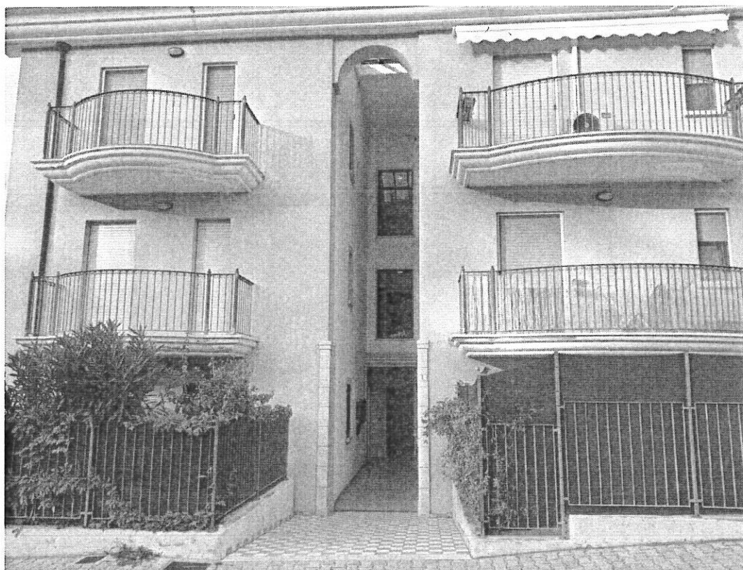
Vialetto di ingresso alla palazzina
