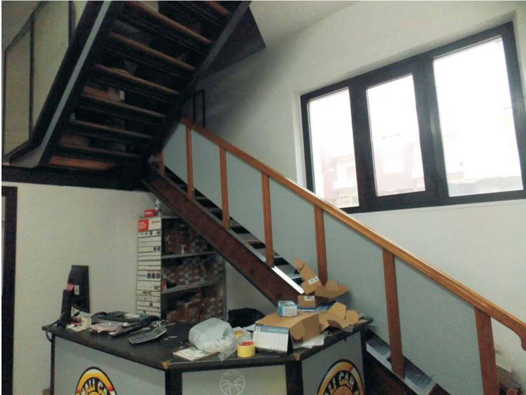
Foto A.3 Scala di collegamento interna
