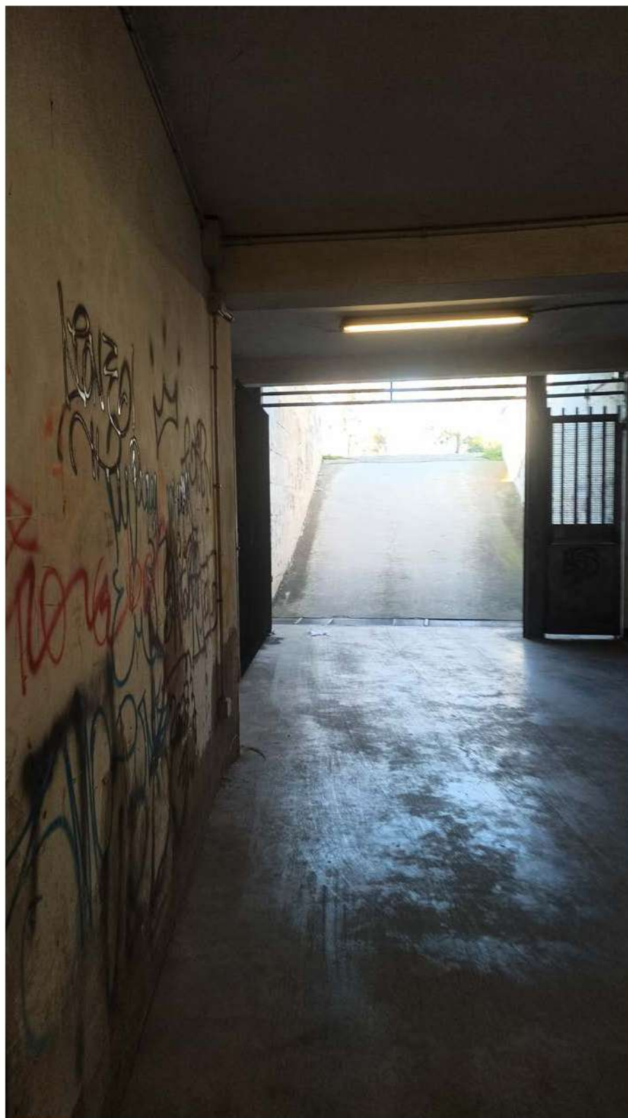
FOTO 22 – RAMPA DI ACCESSO ALLE CANTINE E AI GARAGE
