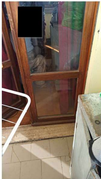
FOTO 20 – DETTAGLIO PAVIMENTO E INFISSO BALCONE
