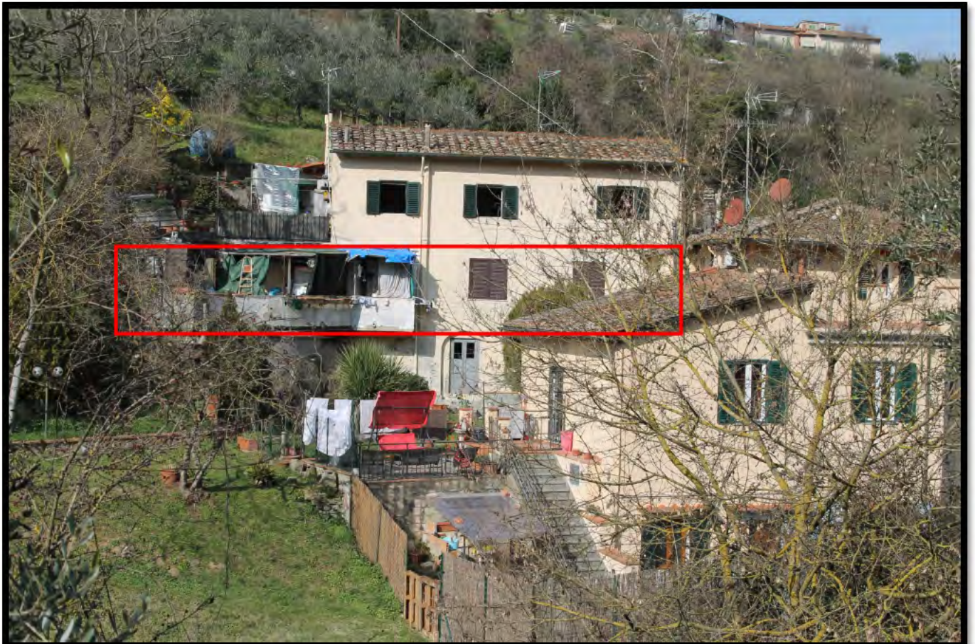
2. Prospetto dell'edificio da via Vecchia Pisana e individuazione dell'appartamento pignorato
