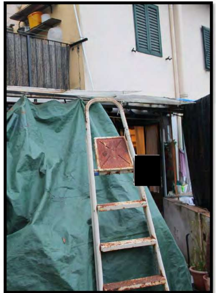
23 La terrazza con la copertura precaria.
