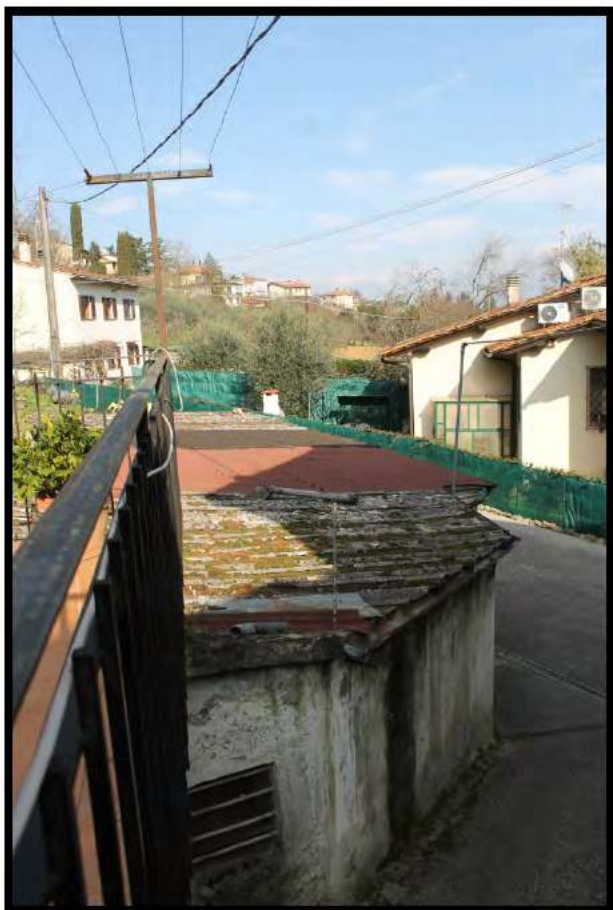
7- Vista delle coperture delle autorimesse
