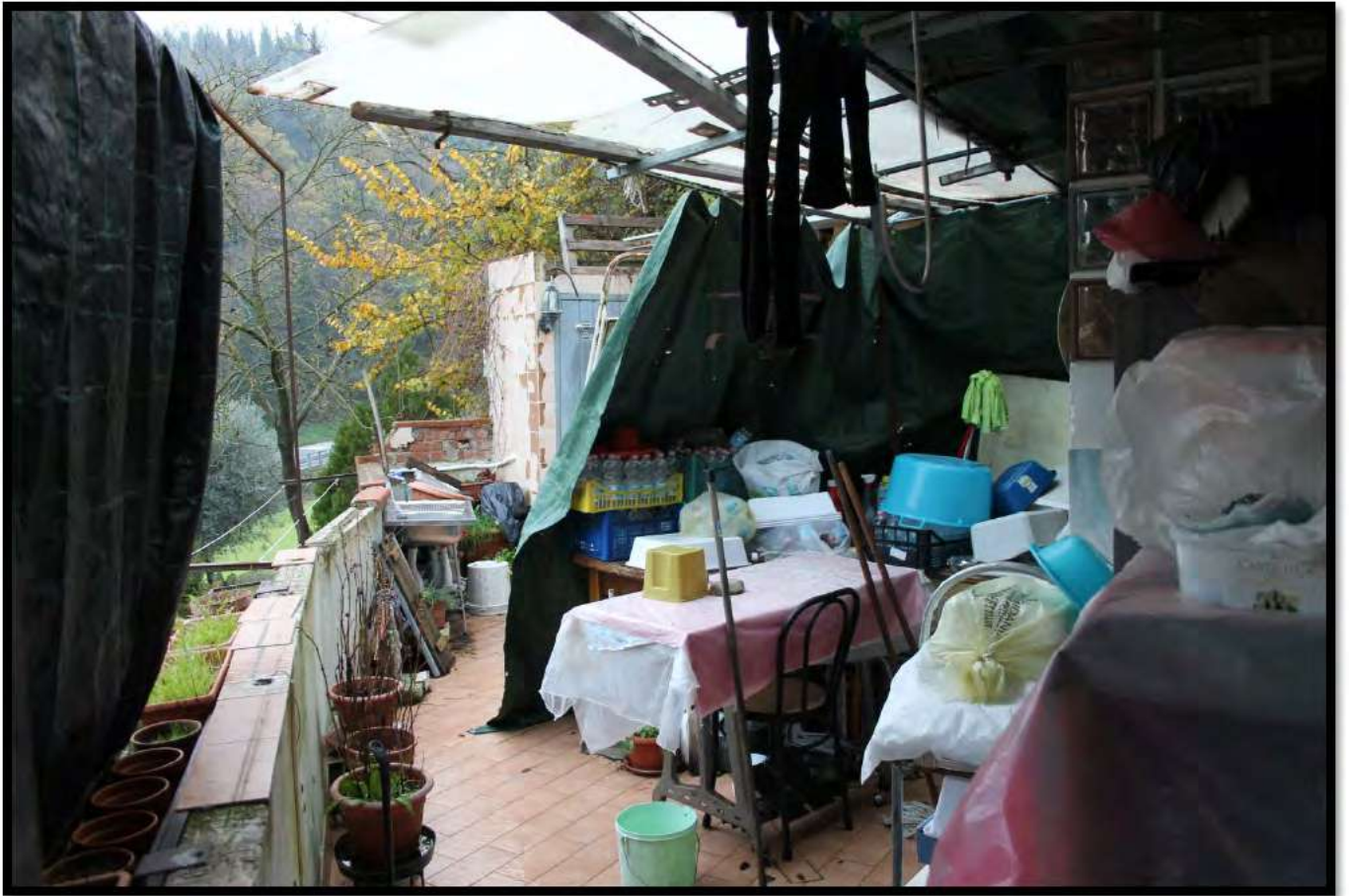
21. Vista della terrazza :con la copertura precaria
