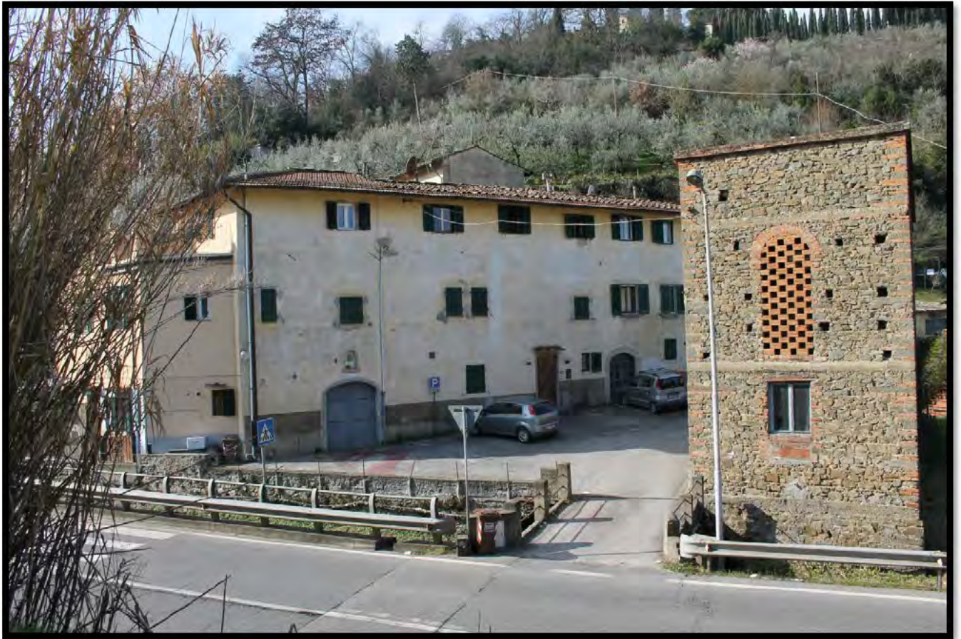
1. Accesso da via Vecchia Pisana tramite il ponte sul rio Rimaggio
