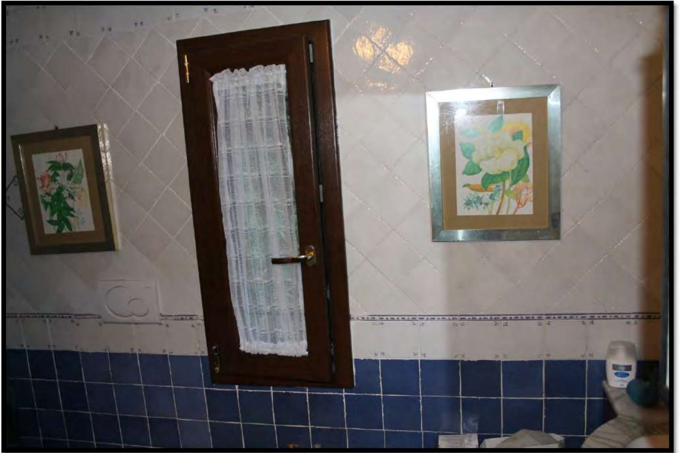
19. Finestra del bagno
