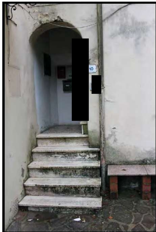
8. Accesso al vano scale dalla corte comune
