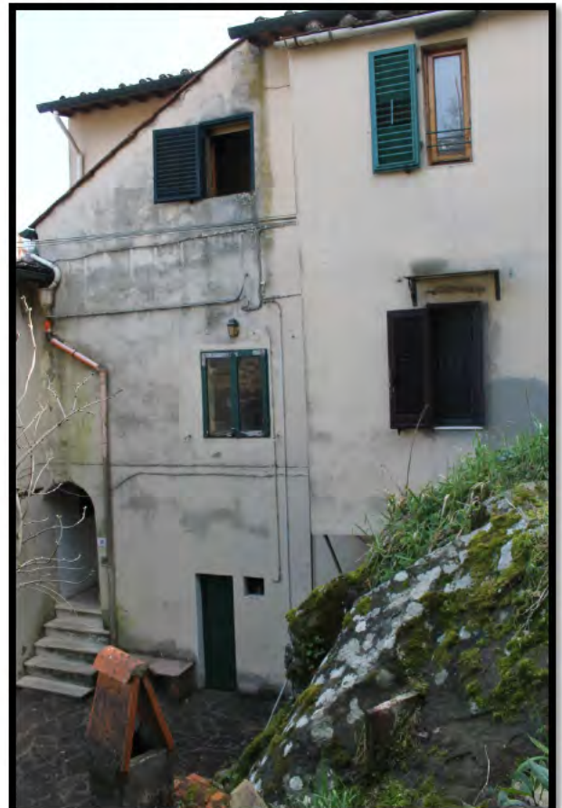
5. Vista del prospetto tergale
