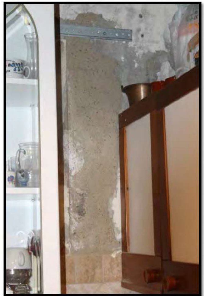
14. Tracce di muffa nell'angolo della cucina
