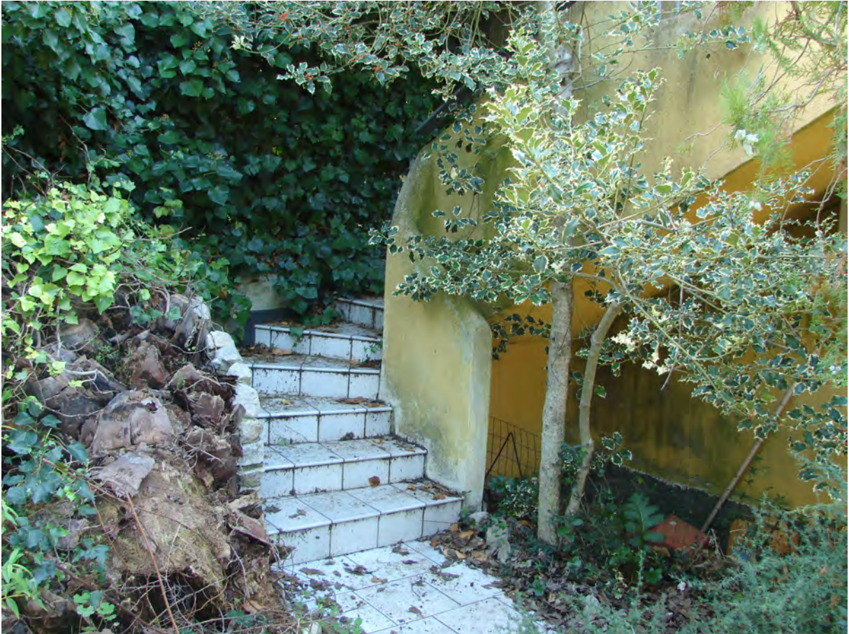
Foto n. 3_13 - Vista della scala esterna che conduce al piano primo del fabbricato adibito ad abitazione sito in territorio di Enna in c.da Jacopo, ricadente in Catasto sul foglio n. 167 part. 933
