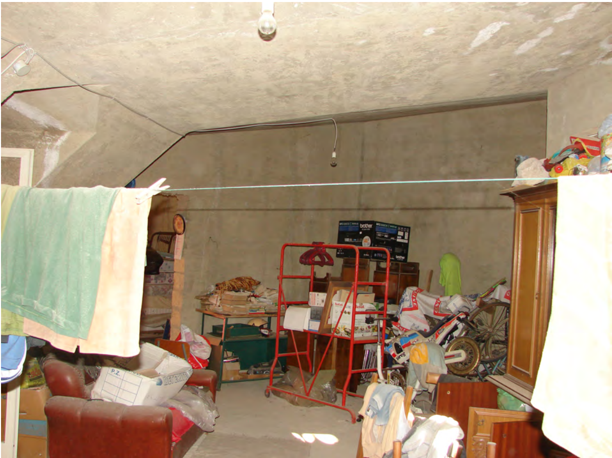
Foto n. 3_16 - Vista del piano primo del fabbricato adibito ad abitazione sito in territorio di Enna in c.da Jacopo, ricadente in Catasto sul foglio n. 167 part. 933
