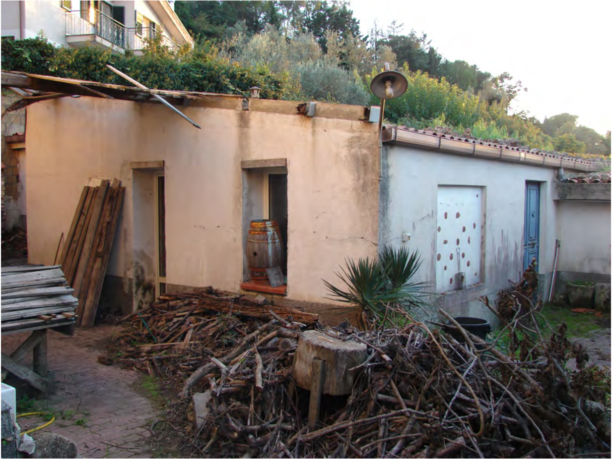
Foto n. 3_19 - Vista esterna del fabbricato adibito a deposito sito in territorio di Enna in c.da Jacopo, ricadente in Catasto sul foglio n. 167 part. 933
