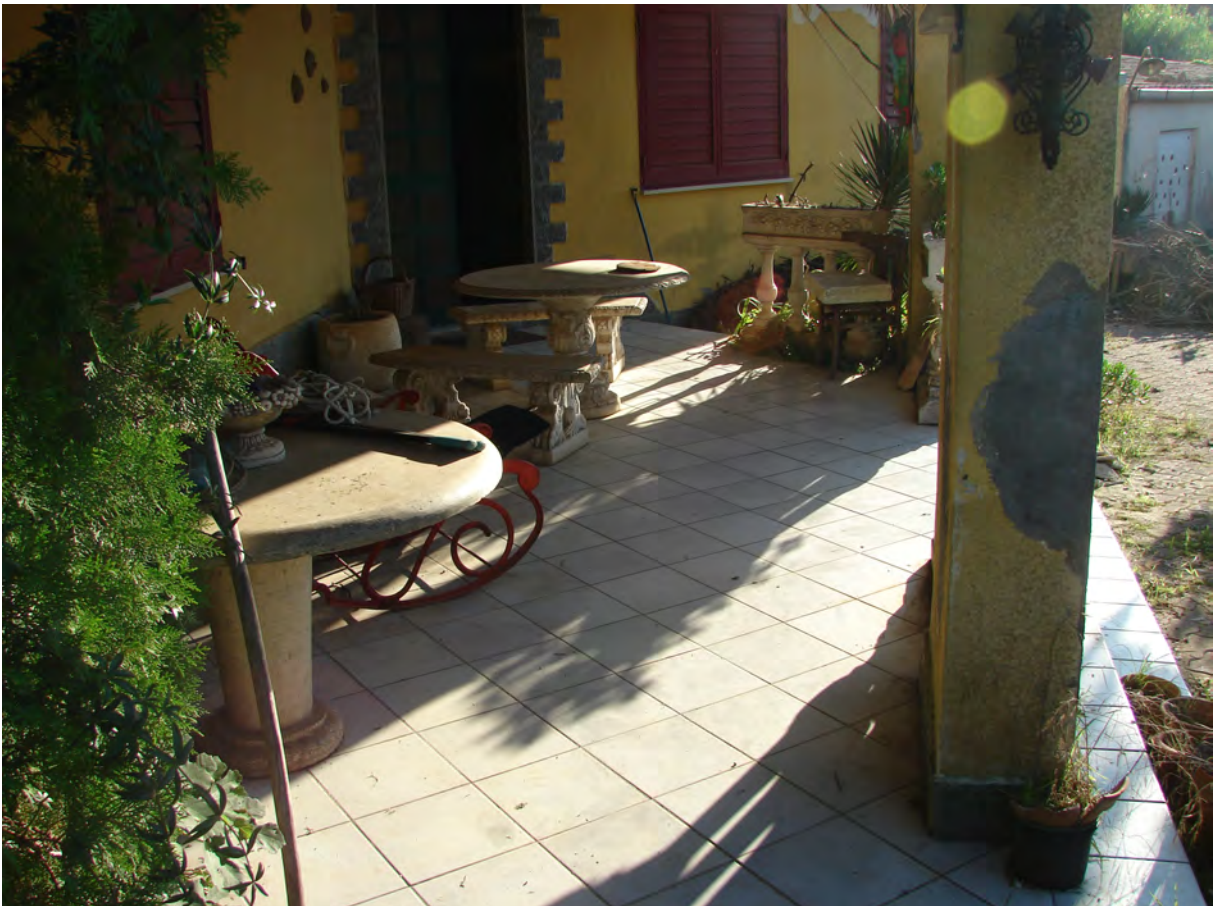
Foto n. 3_4 - Vista del portico al piano terra del fabbricato adibito ad abitazione sito in territorio di Enna in c.da Jacopo, ricadente in Catasto sul foglio n. 167 part. 933
