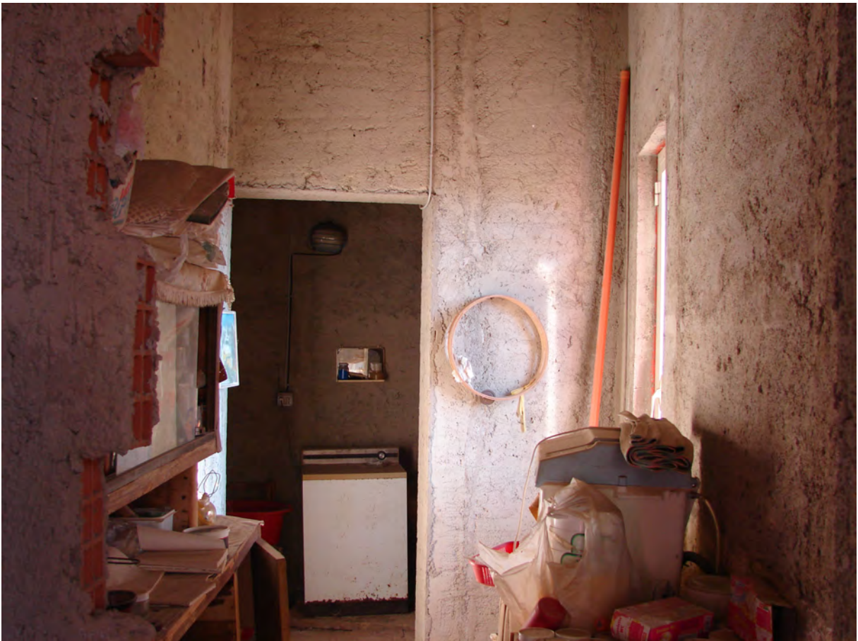
Foto n. 3_18 - Vista del piano primo del fabbricato adibito ad abitazione sito in territorio di Enna in c.da Jacopo, ricadente in Catasto sul foglio n. 167 part. 933
