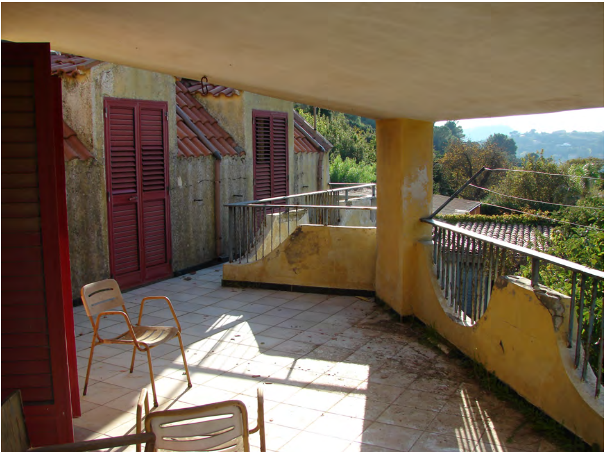
Foto n. 3_14 - Vista del terrazzo al piano primo del fabbricato adibito ad abitazione sito in territorio di Enna in c.da Jacopo, ricadente in Catasto sul foglio n. 167 part. 933
