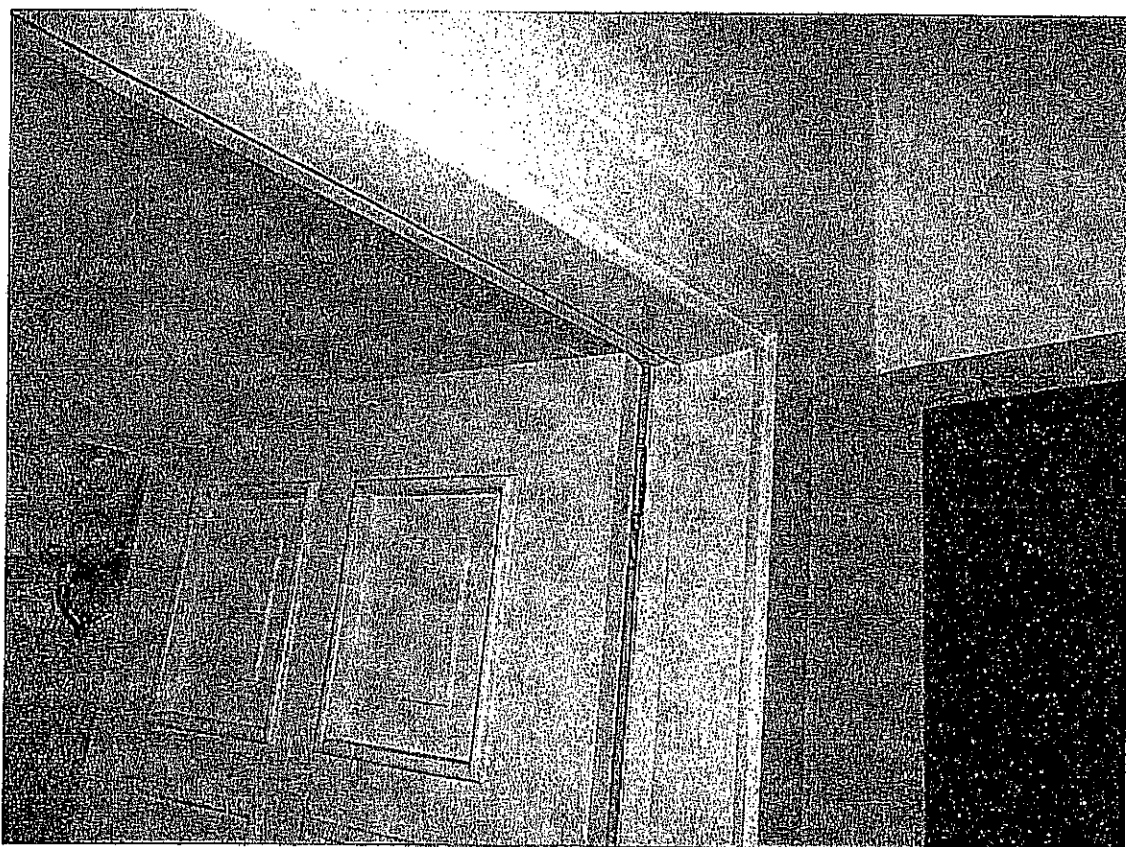
Foto n° 6 – Particolare delle porte
