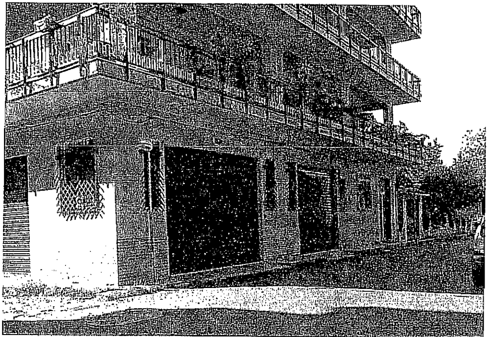
Foto n° 2 - Il pian terreno su via T. Campanella
