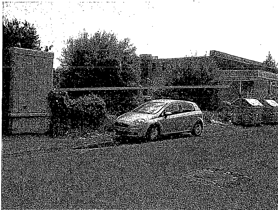
Foto n° 5 – Il fronte sulla SS 111
