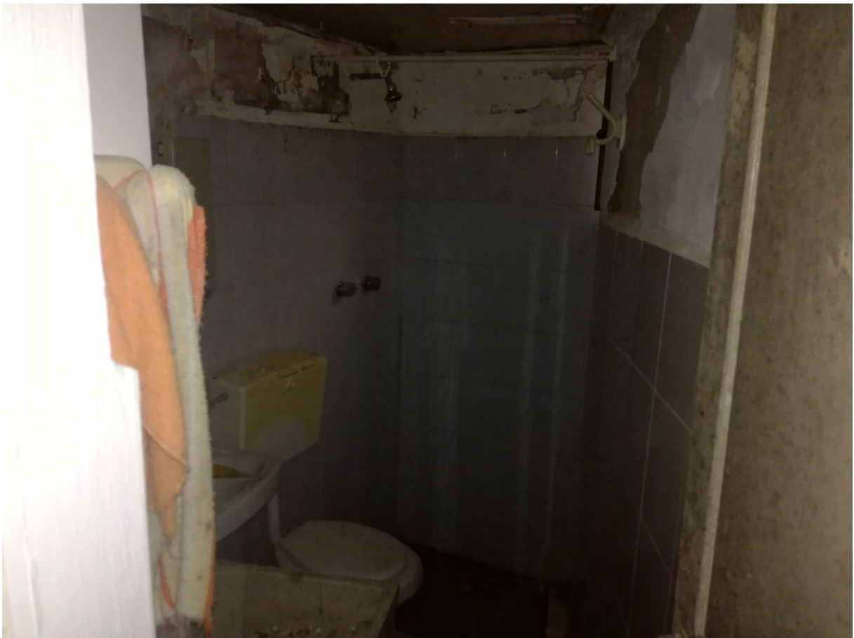
Foto n. 1_7 - Vista del bagno a piano terra del fabbricato sito a Enna alla via Camiolo n. 48, censito in Catasto al foglio n. 39, Sez. Urb. F, part. n. 11503 sub 4 e 5
