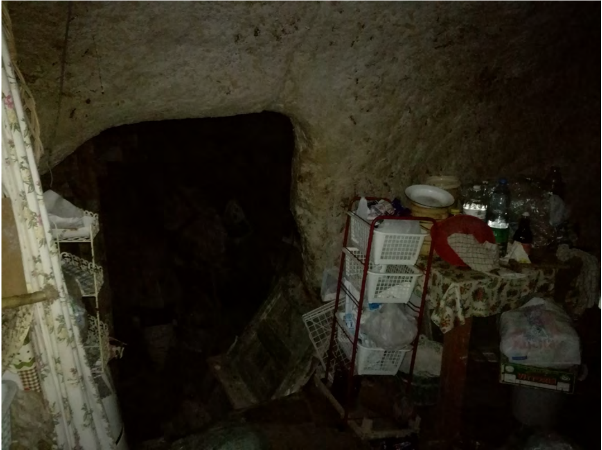
Foto n. 1_8 - Vista dell'ingrottato a piano terra del fabbricato sito a Enna alla via Camiolo n. 48, censito in Catasto al foglio n. 39, Sez. Urb. F, part. n. 11503 sub 4 e 5
