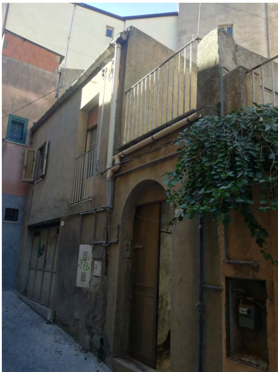
Foto n. 1_1 - Vista esterna dalla via Camiolo del fabbricato sito a Enna alla via Camiolo n. 48, censito in Catasto Fabbricati al foglio n. 39, Sez. Urb. F, part. n. 11503 sub 4 e 5
