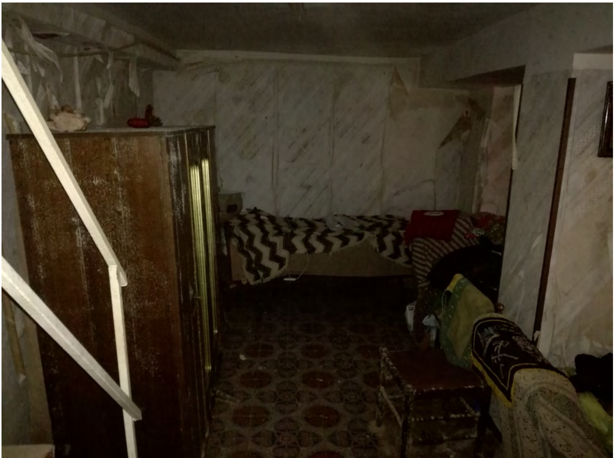
Foto n. 1_5 - Vista della ribatteria a piano terra del fabbricato sito a Enna alla via Camiolo n. 48, censito in Catasto al foglio n. 39, Sez. Urb. F, part. n. 11503 sub 4 e 5
