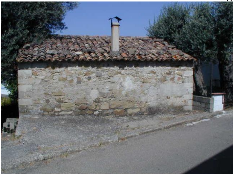
Esterno deposito sub 1
