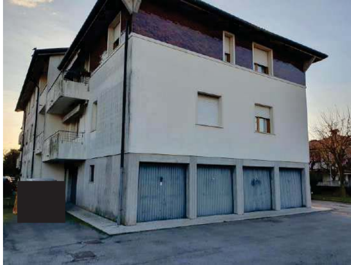
FOTO 2: vista lato ovest
