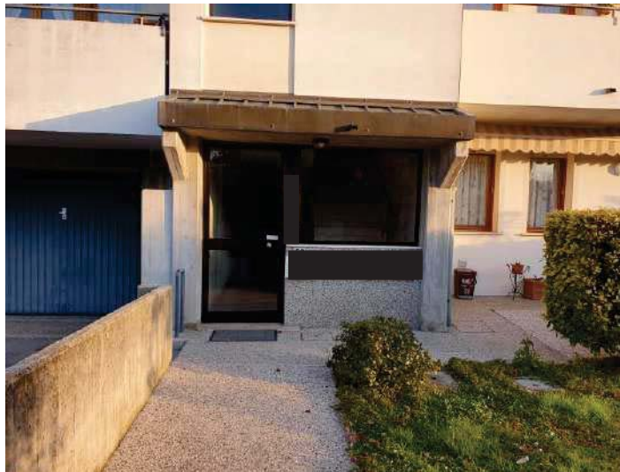
FOTO 3: vista vano scala esterno – lato sud
