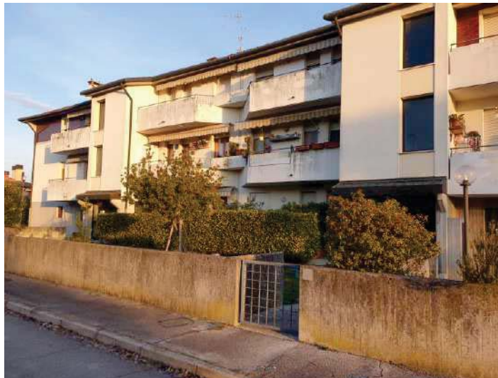
FOTO 1 : vista lato sud
