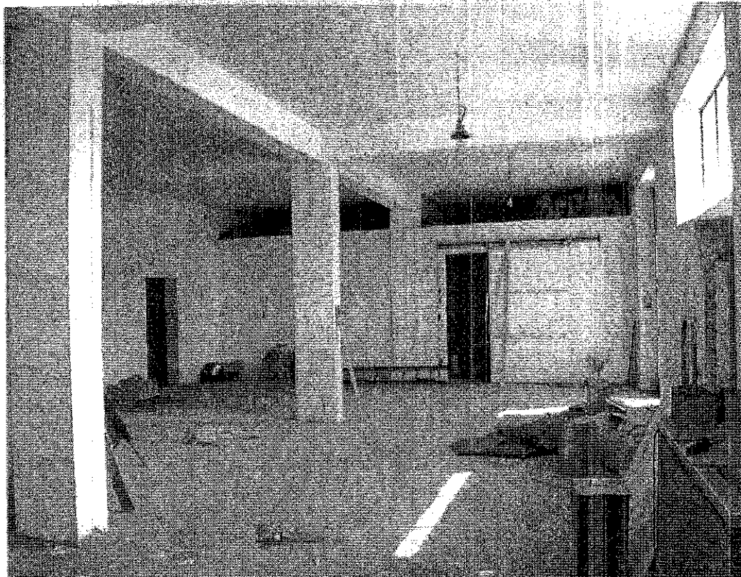
CAPANNONE - ZONA LAVORAZIONE ORTAGGIE E CELLA FRIGO
