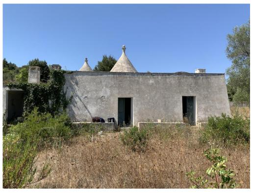
In ultimo, in adiacenza al forno a legna sul lato sinistro dello stesso è presente una superfetazione costituita da un ripostiglio esterno, allo stato attuale privo di copertura, realizzato a mezzo di murature in conci di tufo per una superfice di 5,80 mq, che si presume non legittimato sotto il profilo urbanistico-edilizio.
