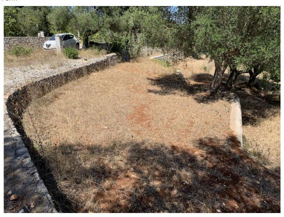
Lungo i confini verso monte è presente un sistema di recinzione con tipici muri in pietra calcarea a secco, di altezza variabile ed a sezione gradonata, con ulteriore delimitazione a mezzo di paletti in ferro di sostegno di rete metallica plastificata.
