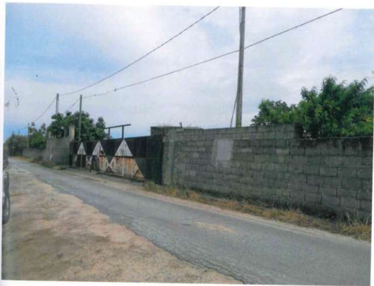
Muro recinzione lato ingresso strada IV stradone
