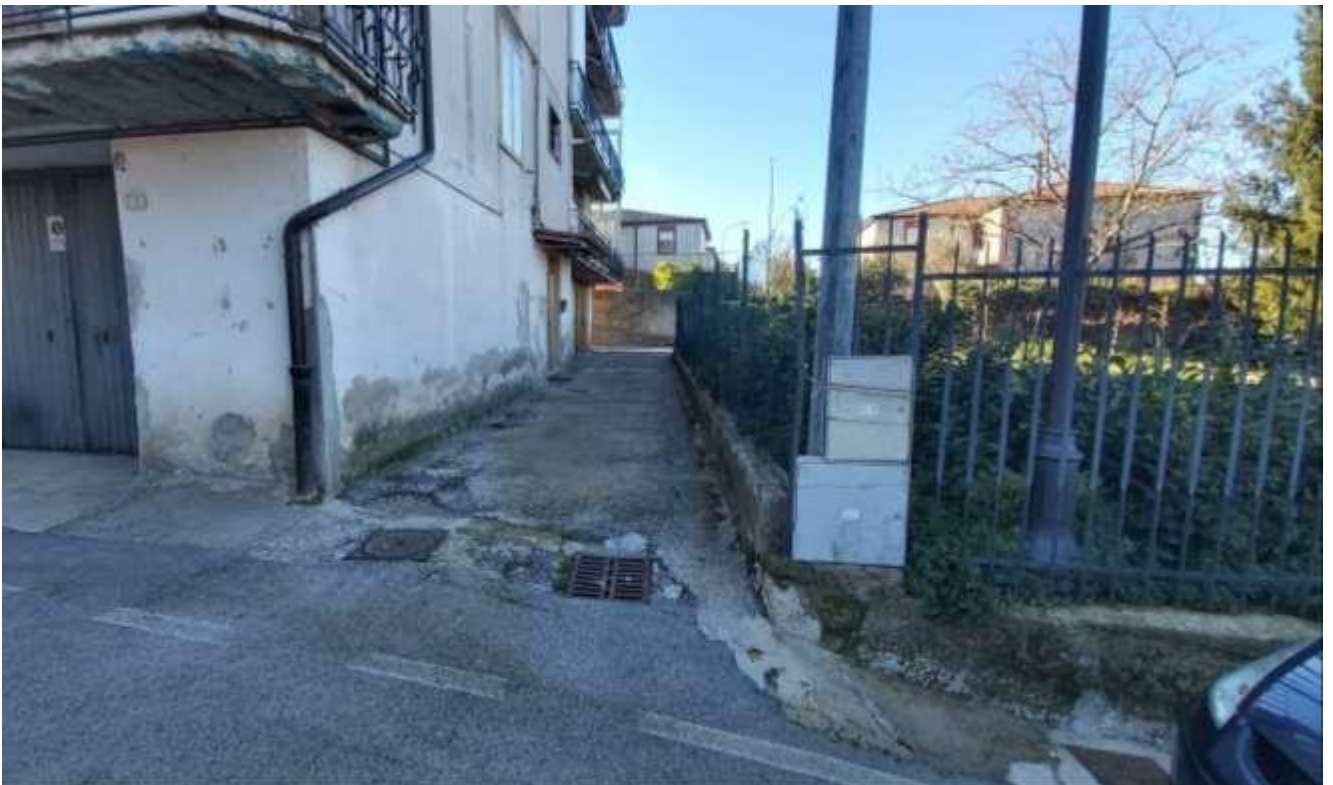
Foto 2. L'ingresso al cortile condominiale dalla strada comunale "Via Ponte".
