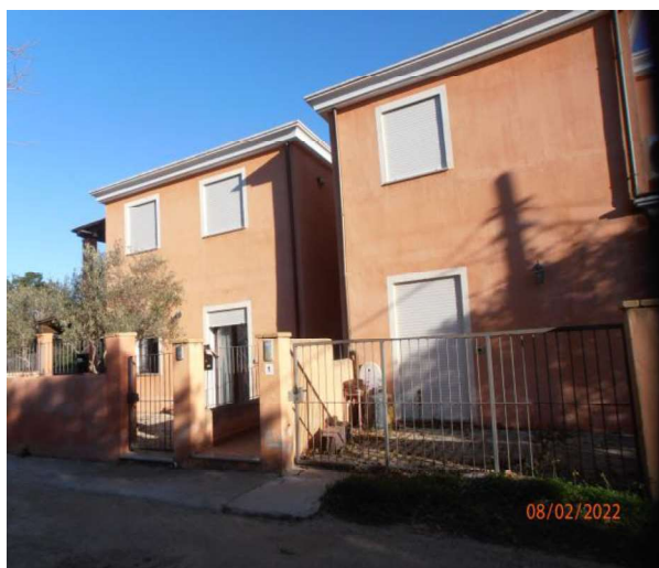
Via Casalis n.1 - Lato Ingresso
