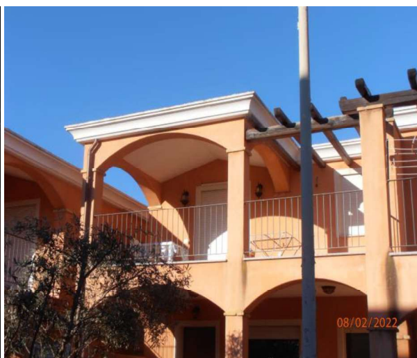
Via Casalis - Lato Veranda e terrazza
