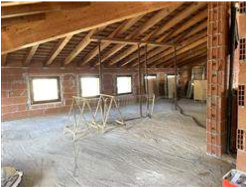
Soffitta in corso di costruzione al piano secondo.
