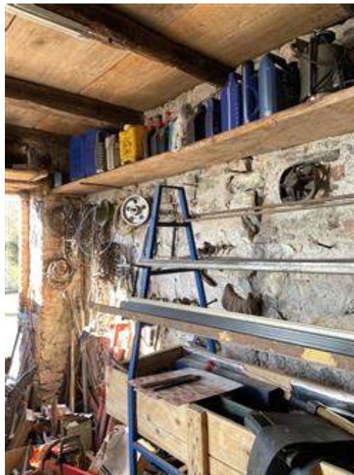
Vista interna del vano piano terra.
