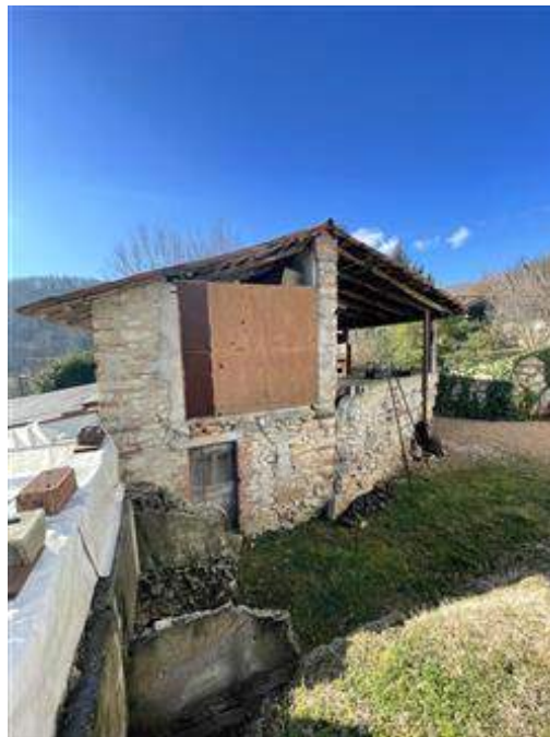
Vista esterna da nord.
