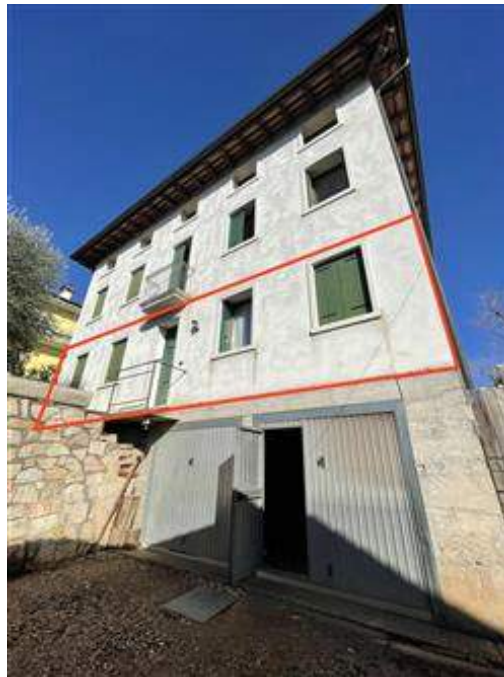
Vista esterna da sud ovest (contorni indicativi sul sub. 3).
