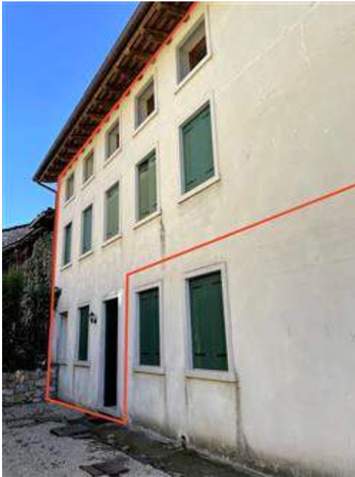
Vista esterna da nord ovest (contorni indicativi sul sub. 2)
