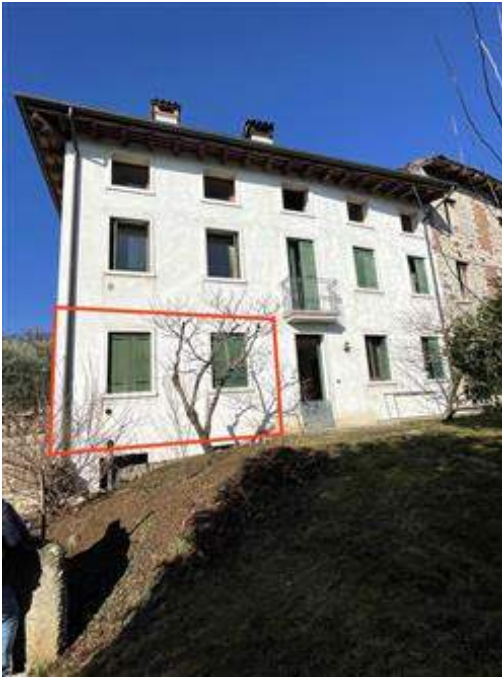
Vista esterna da sud est (contorni indicativi sull'unità sub. 3).
