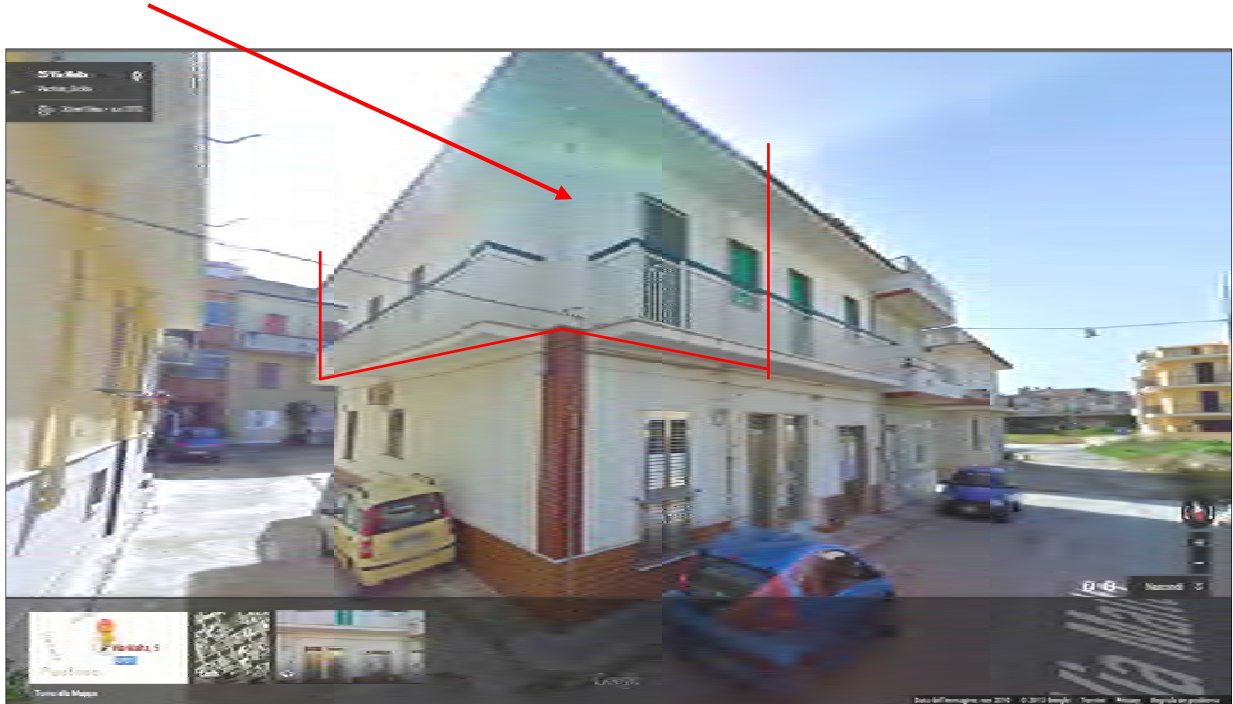
Foto n. 3 – Edificio di via Malta n° 5, immobile ad angolo al primo piano
