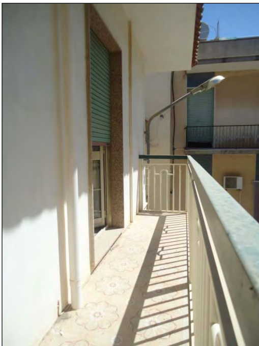
Foto n.17 – Balcone 1 a sud
