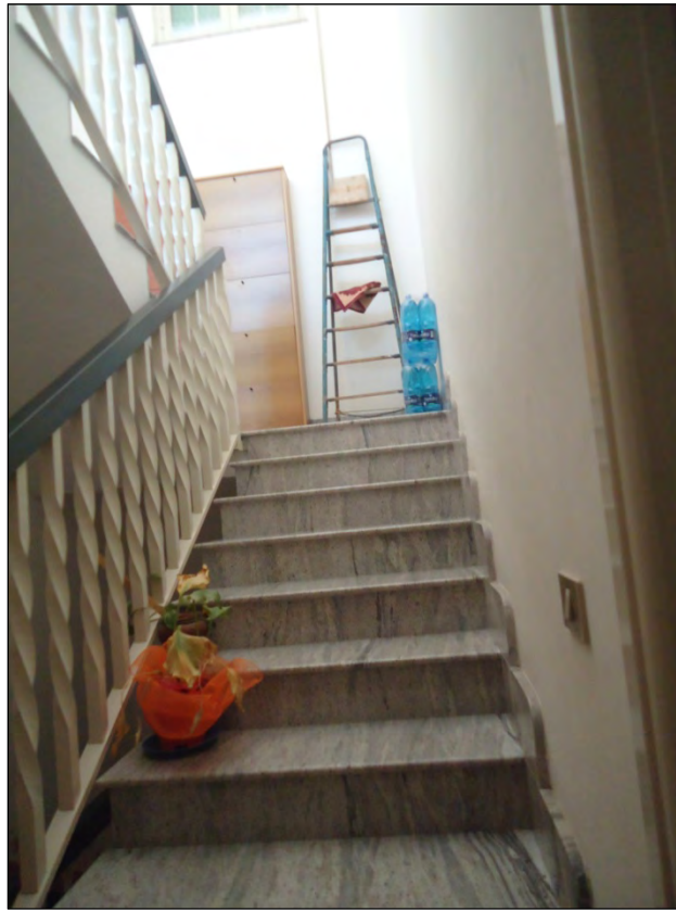
Foto n. 7 – Scale condominiali dal piano primo al lastrico solare
