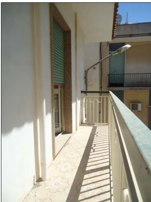
Foto n.17 – Balcone 1 a sud
