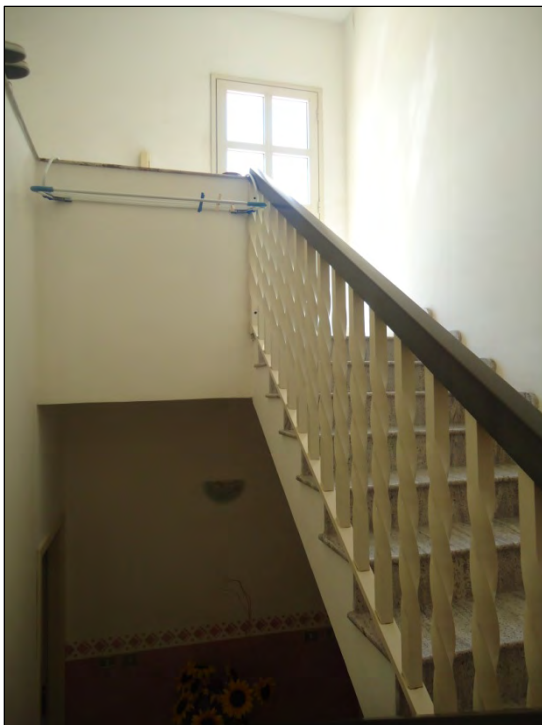
Foto n. 8 – Arrivo al lastrico solare
