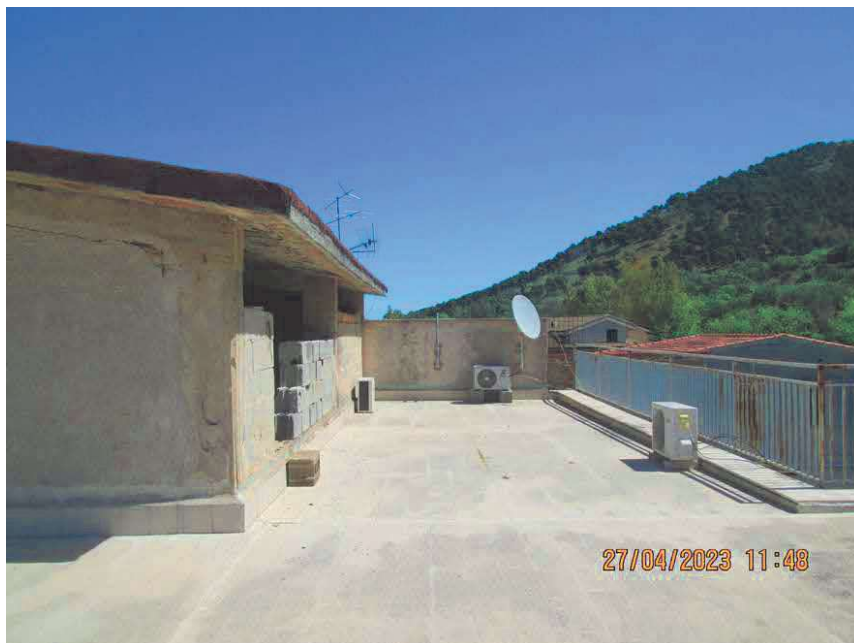
Foto 22. Locale stenditoio e terrazza. Lato sud-est
