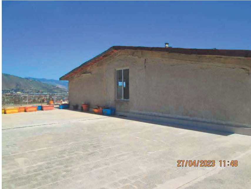
Foto 21. Locale stenditoio e terrazza. Lato sud-ovest
