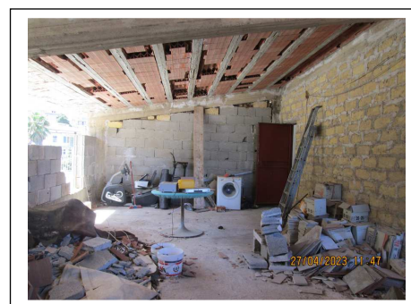
Foto 12. Interno del locale stenditoio. Lato sud-est
