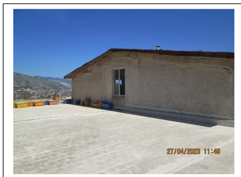
Foto 21. Locale stenditoio e terrazza. Lato sud-ovest
