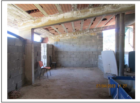
Foto 13. Interno del locale stenditoio. Lato nord-ovest
