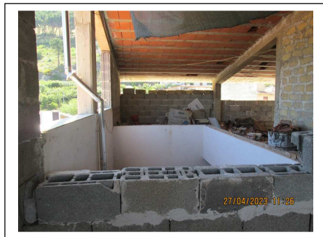
Foto 18. Locale stenditoio. Chiostrina interna
