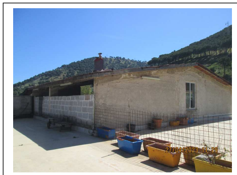
Foto 19. Locale stenditoio e terrazza. Lato nord-ovest e sud-ovest
