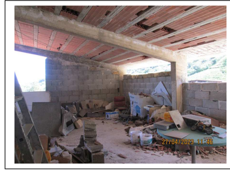
Foto 14. Interno del locale stenditoio. Lato sud-est
