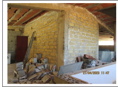
Foto 16. Locale stenditoio. Corpo scala
