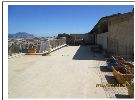
Foto 20. Locale stenditoio e terrazza. Lato nord-ovest
