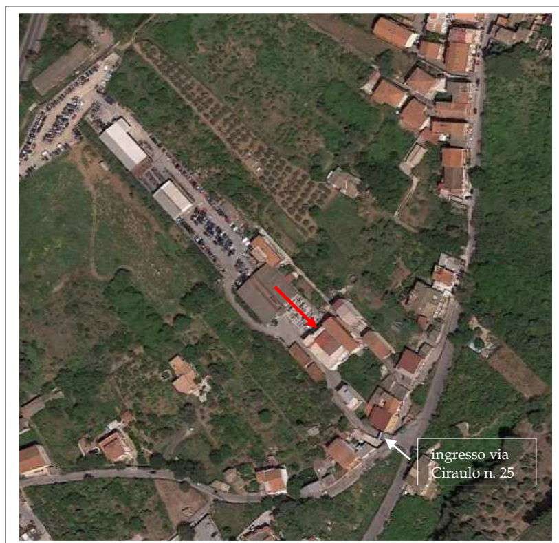
Fig. 3. Aerofoto tratta da Google Earth. Con la freccia rossa è indicato l'edificio di cui fa parte il bene pignorato. Con la freccia bianca è indicato l'accesso da via Ciraulo n. 25
