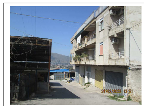
Foto 4. Strada interna al complesso immobiliare di via Ciraulo n. 25. Sulla destra è ubicato il fabbricato di cui fa parte il bene pignorato
