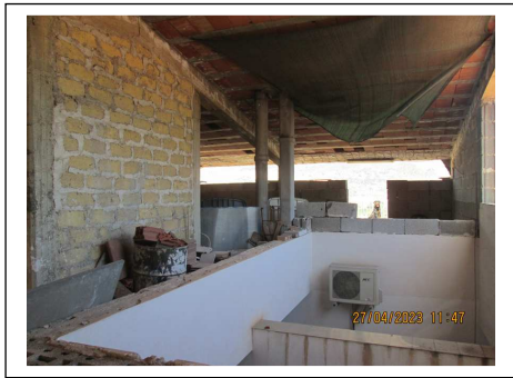
Foto 17. Locale stenditoio. Chiostrina interna
