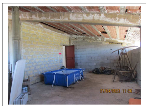
Foto 11. Interno del locale stenditoio. Lato nord-ovest
