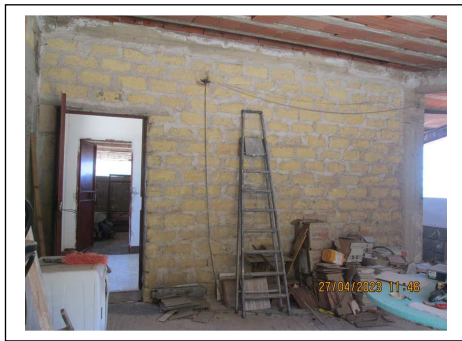
Foto 15. Locale stenditoio. Ingresso del lato sud-est dal corpo scala condominiale.
