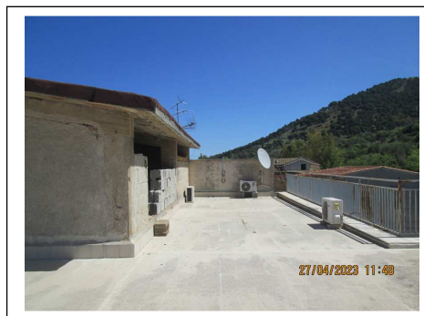
Foto 22. Locale stenditoio e terrazza. Lato sud-est
