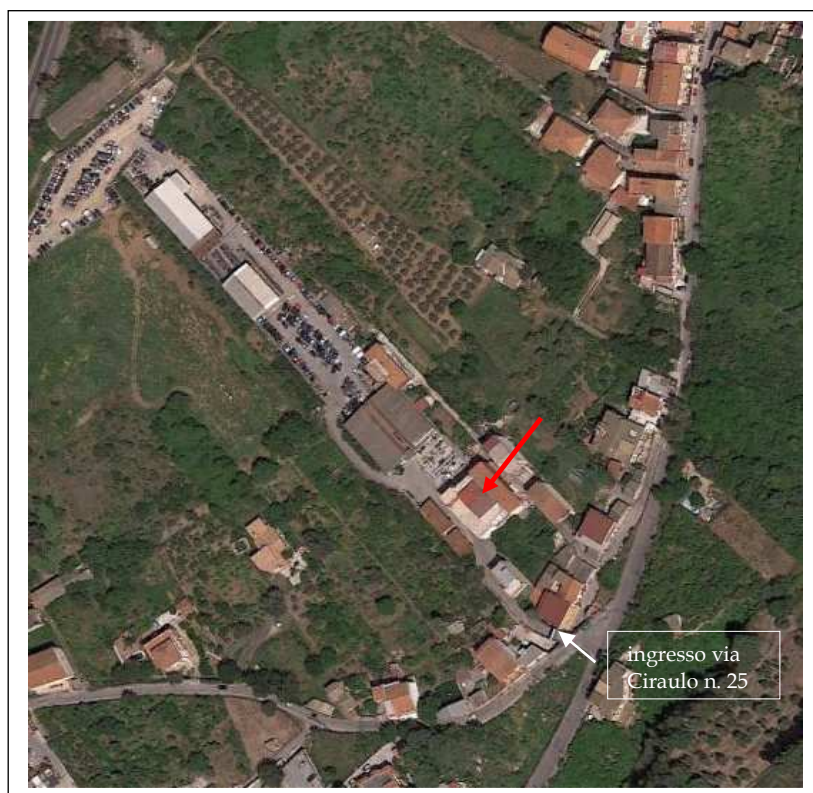
Fig. 3. Aerofoto tratta da Google Earth. Con la freccia rossa è indicato l'edificio di cui fa parte il bene pignorato. Con la freccia bianca è indicato l'accesso da via Ciraulo n. 25
