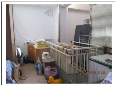
Foto 35. Balcone della cucina/lavanderia
