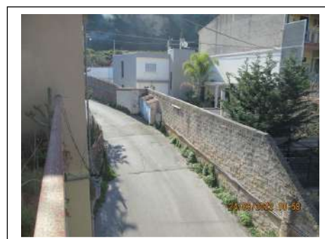
Foto 2. La stradella di accesso al fabbricato di cui fa parte l'immobile pignorato dal civico n. 25 di via Ciraulo
